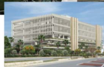
国際ロジスティクスセンター4号棟
