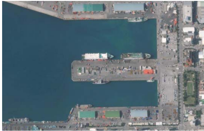
■くし型のかつ頭のたけ、荷役作戦のスペースが狭く、大型化した船舶の積載能力に見合っていない。
