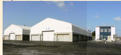
建屋及びストックヤード (酒田港)
