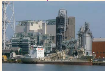
岸壁直背後に立地するセメント工場 (姫川港)
