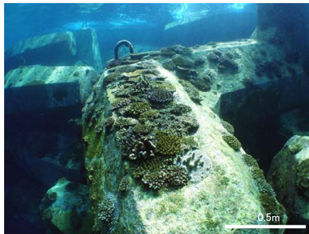
図-1.1 凹凸加工部分へ集中的に加入・着生したサンゴ群集（那覇港，2007）
