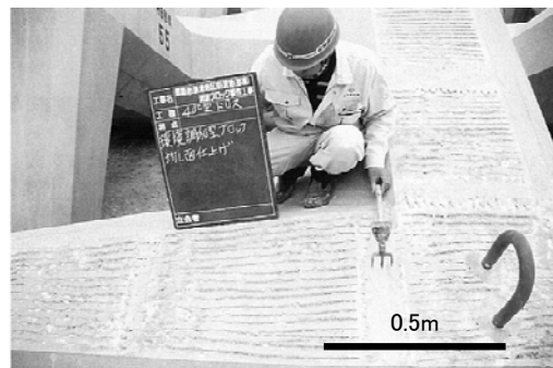
(1) 打設口部分の凹凸加工イメージ：那覇港のエコブロック
