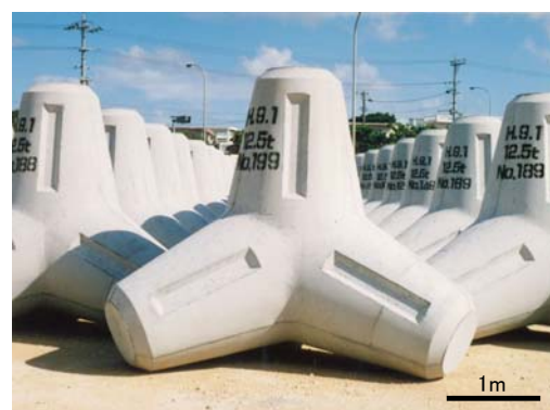
(3) 型枠による凹凸加工のイメージ：平良港の溝加工ブロック
