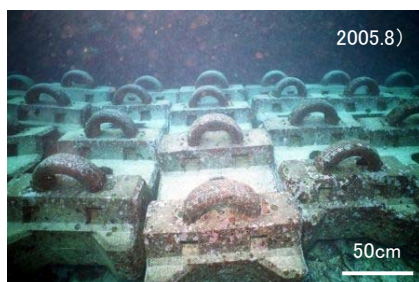
図 被覆ブロックの設置状況
