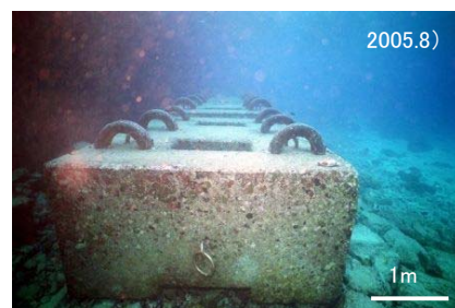
図 根固ブロックの設置状況
