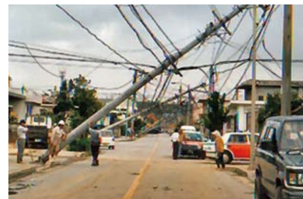
台風による電柱倒壊(H15年)(宮古島市)
