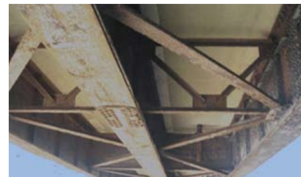
塩害による腐食が進行した橋梁
