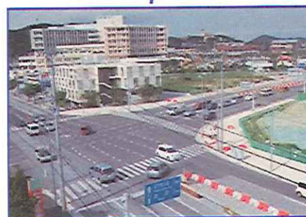
南風原バイパス 部分供用区間
