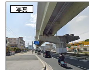
仮設ランプ(側道路から)
