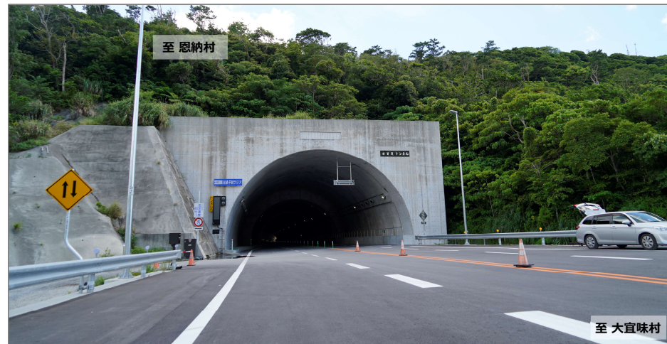
[写真①] 世富慶トンネル付近
