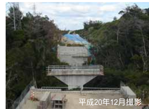
建設中の3号橋
