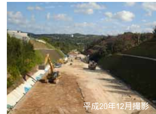
1号跨道橋より起点を望む
