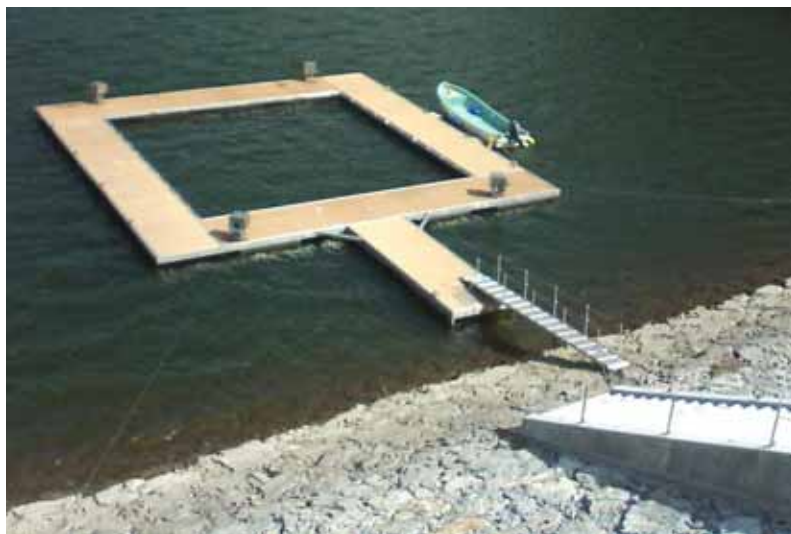
羽地ダムの水質監視用の生け簀
