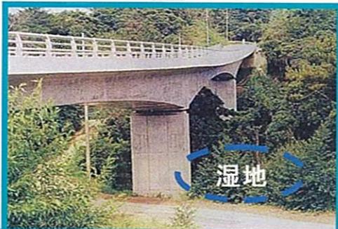
橋梁化による回避措置
