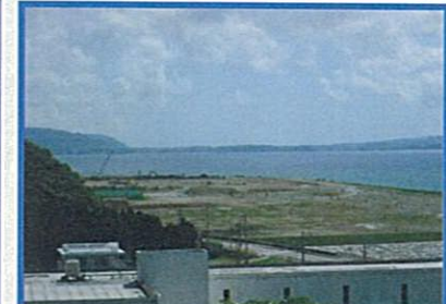
現在は整備工事が進められている
