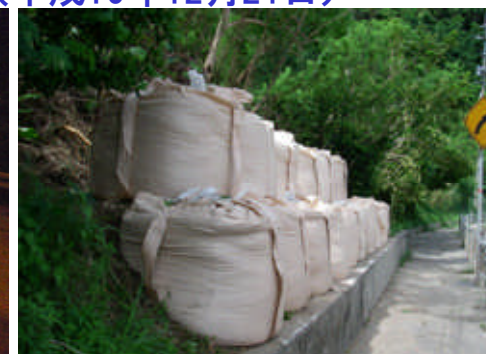
土砂流出抑制応急対策状況
