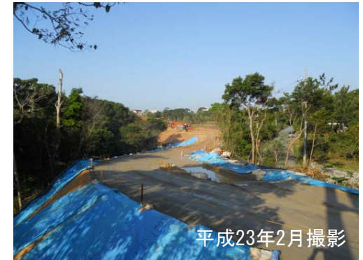
②2工区起点付近
