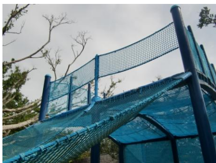
減勢用ネット設置状況
