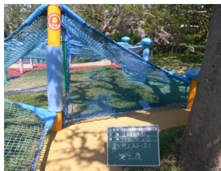
進入防止ネット設置状況
