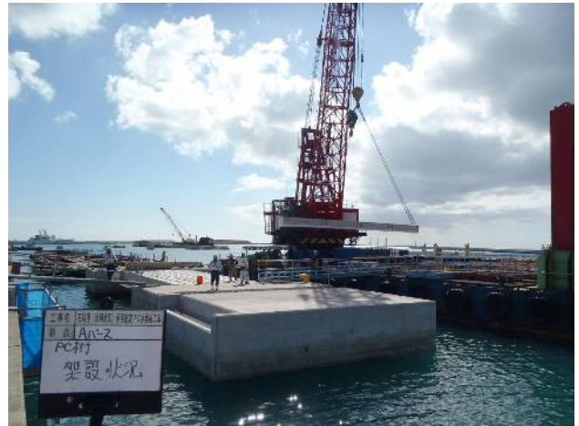
図-12 PC歩廊桁架設
