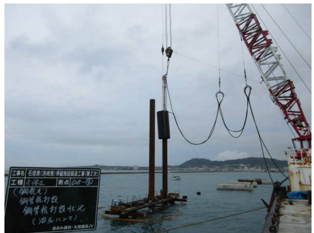
図-8 鋼管杭打設
