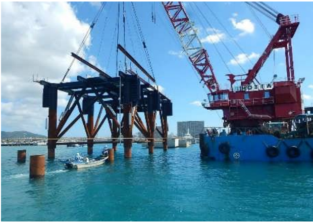
図-9 ジャケット据付
