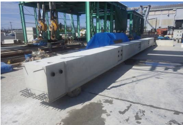
図-11 PC歩廊桁工場製作
