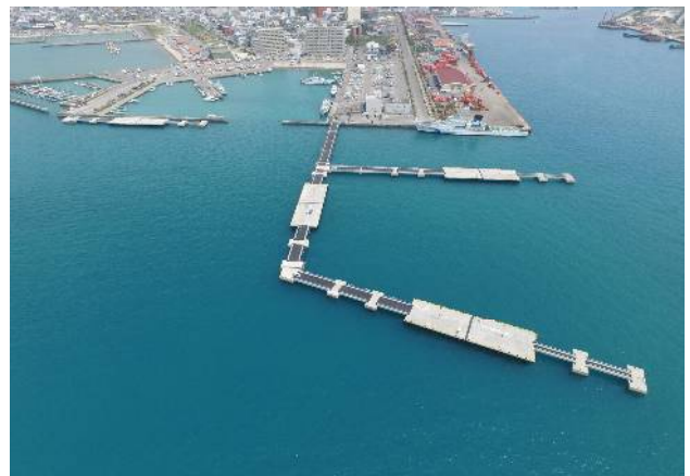
図-13 係留施設完成状況
