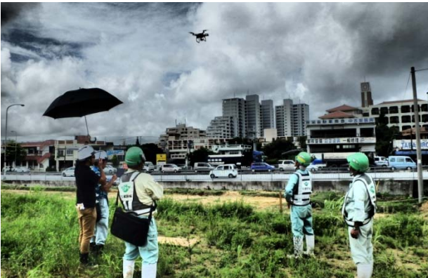
UAV(ドローン)による施工前の測量 (8月9日撮影)
