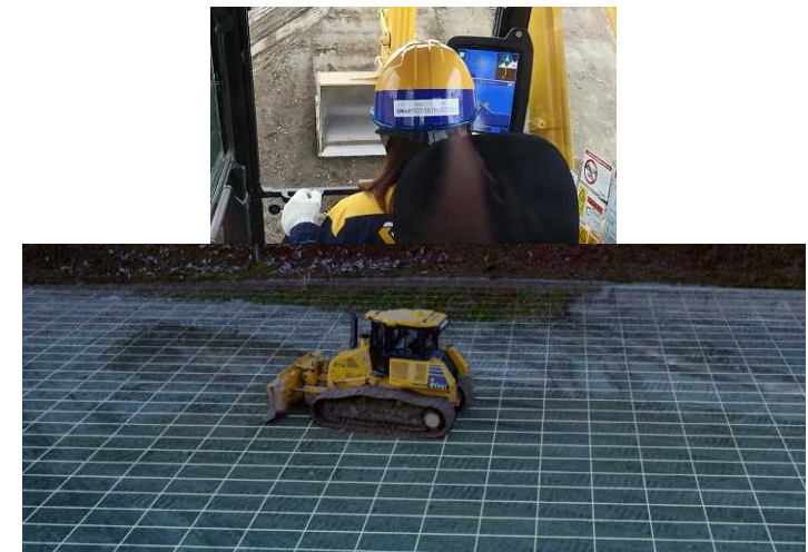
ICT建機による施工
