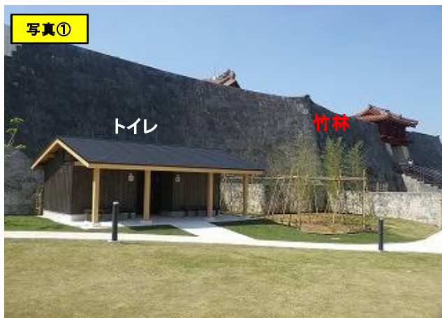
利便性を図るためトイレを整備
