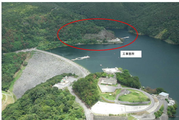
右岸進入路法面補修工事(福地ダム)
