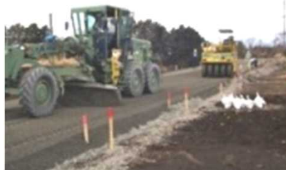
丁張りによる施工
