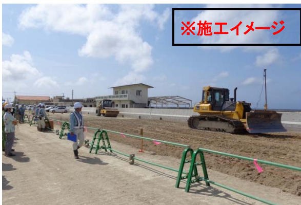
ICTブルドーザによる敷均 (11月中旬 ICT土工施工開始予定)
