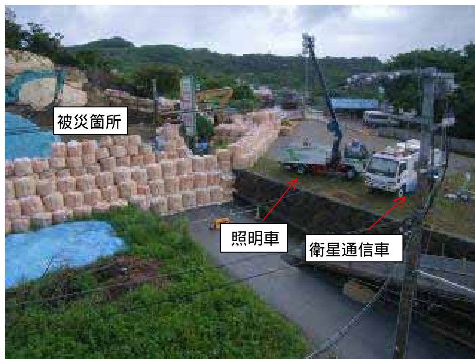
図 0-10 照明車と衛星通信車の活動状況
