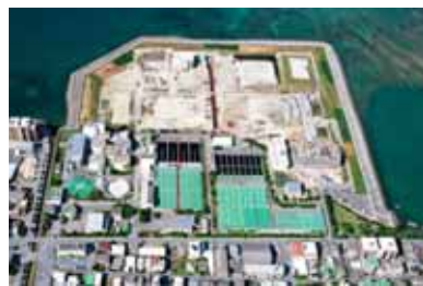
宜野湾浄化センター
