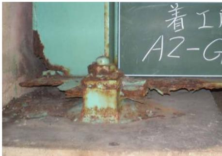
【補修前（支承の損傷）】
