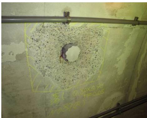
【補修前（コンクリートうき・叩き落とし）】
