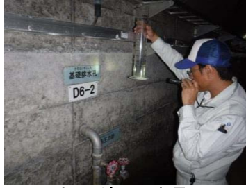
計測(ダム漏水量)
