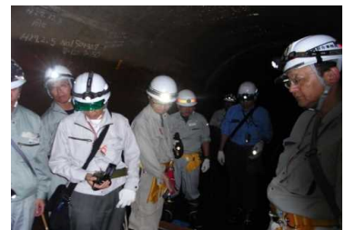
【調整水路トンネル現地調査】
