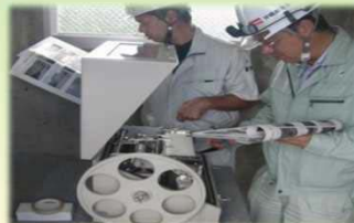
水位計の点検状況
