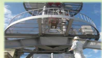
通信機器の点検状況
