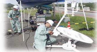
衛星通信機器設置状況
