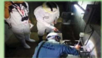
漏水量観測状況
