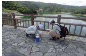
施設点検(羽地ダム)
