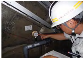
揚圧力測定(安波ダム)
