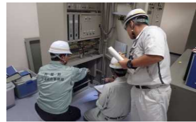
金武ダム訓練状況
