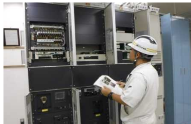
漢那ダム訓練状況
