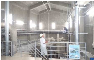
大保ダム訓練状況
