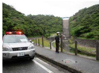
河川巡視状況
