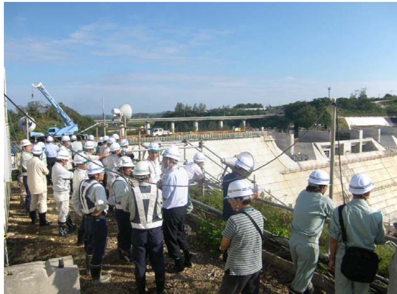
○現場にて施工状況を視察
