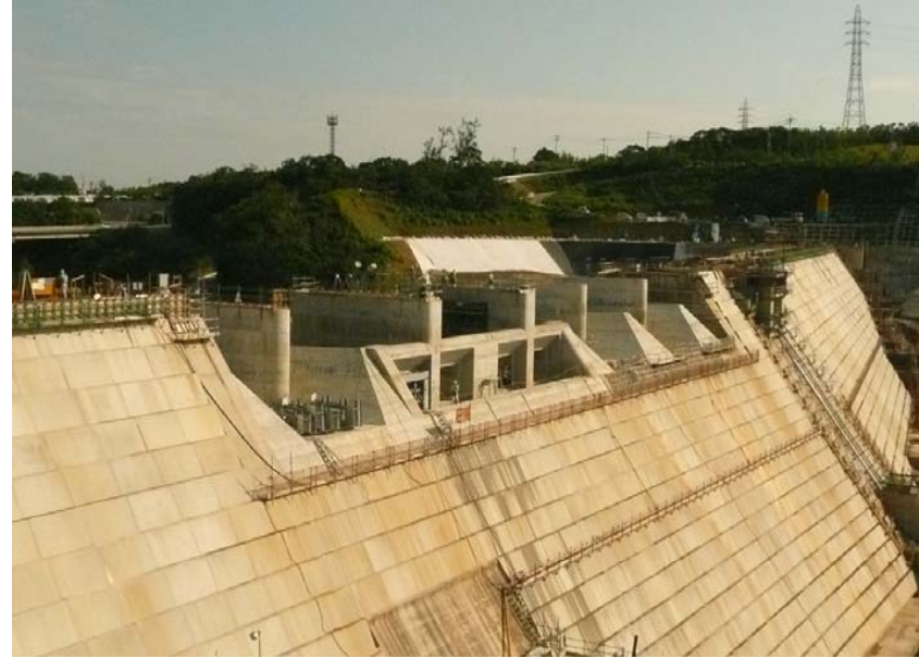
○堤体(上流左岸から)
