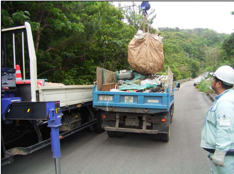
○上流道路周辺撤去状況
