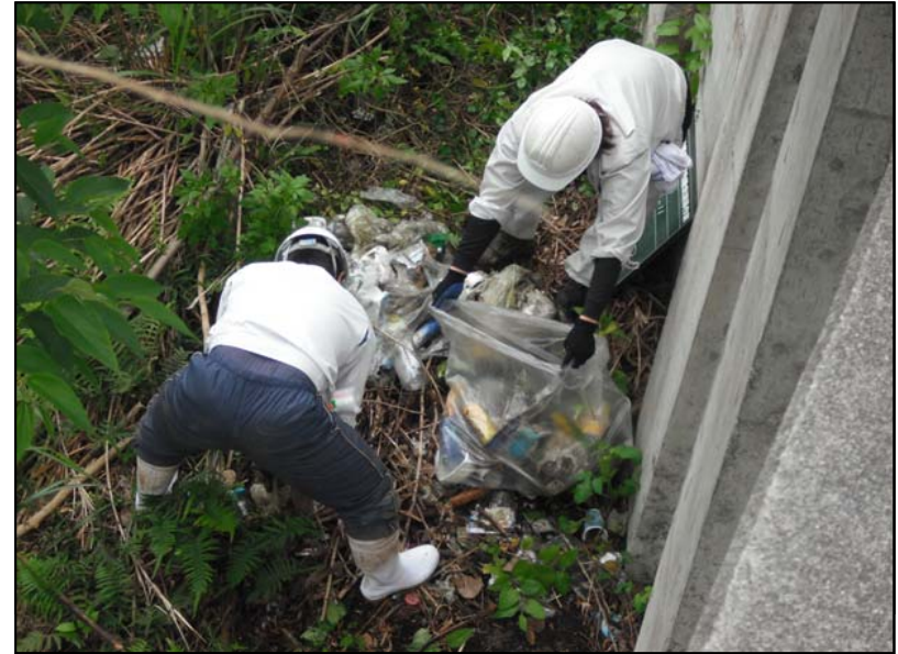
○上流道路周辺撤去状況②
