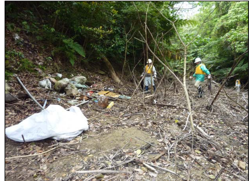
○上流ダム湖岸撤去状況
