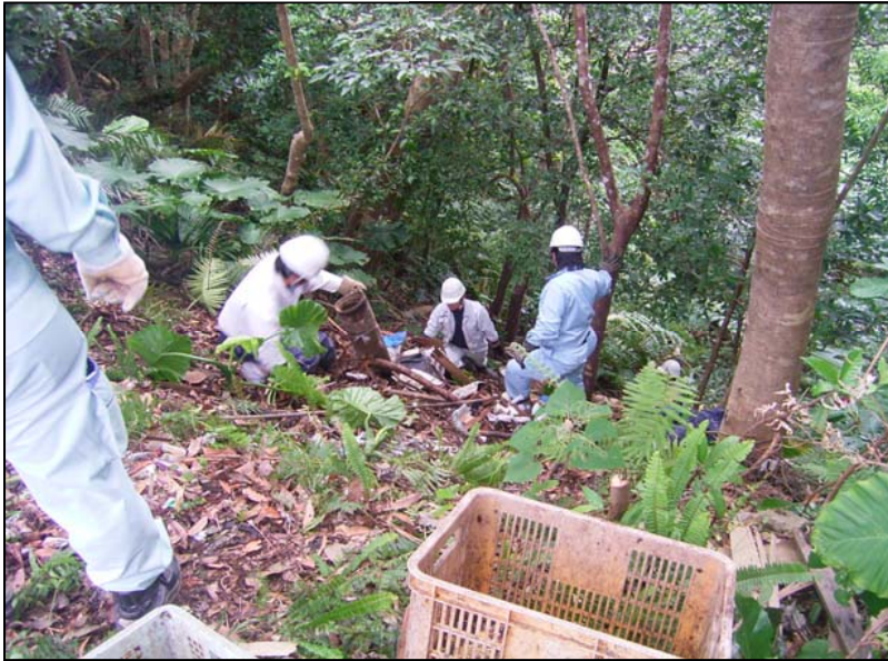
○上流道路周辺撤去状況①
