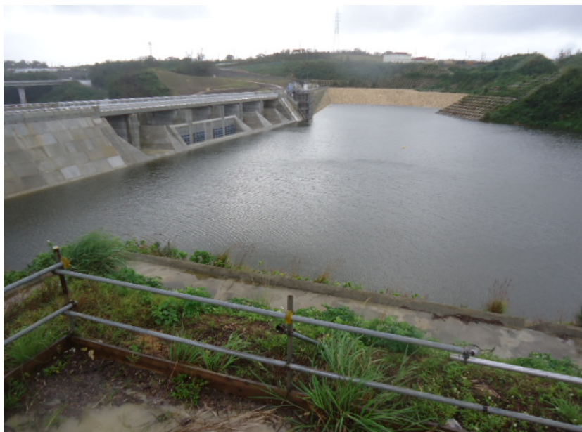
億首ダム堤体上流左岸 より貯水池を望む
