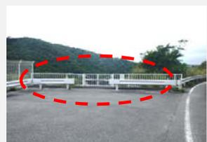
堤体右岸監査廊入口進入防止柵の高さが低く、利用者(子供)が進入して転落する恐れがある為、対応が必要。
