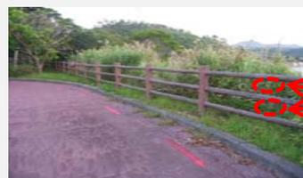
右岸展望広場の手すり隙間が大きく、転落の危険があるので、すり抜け防止ビームを設置する必要がある。
