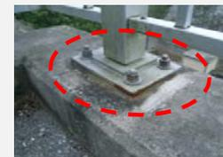
堤体天端部転落防止柵の腐食の処置(錆落とし・塗装等)が必要。
