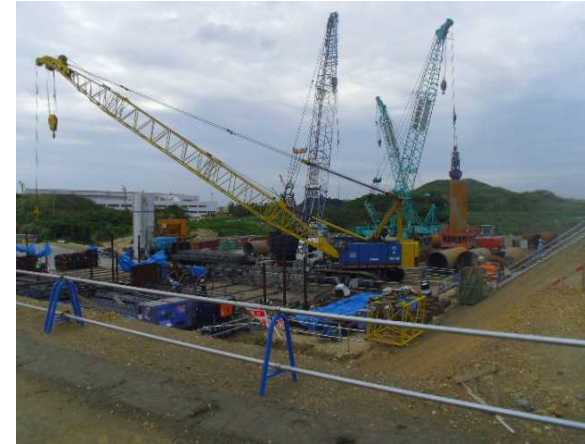
③ 管制塔工事 杭工事施工状況 (平成29年4月撮影)
