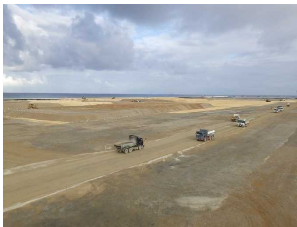
② 【Ⅲ工区】全景 (平成29年1月撮影)
