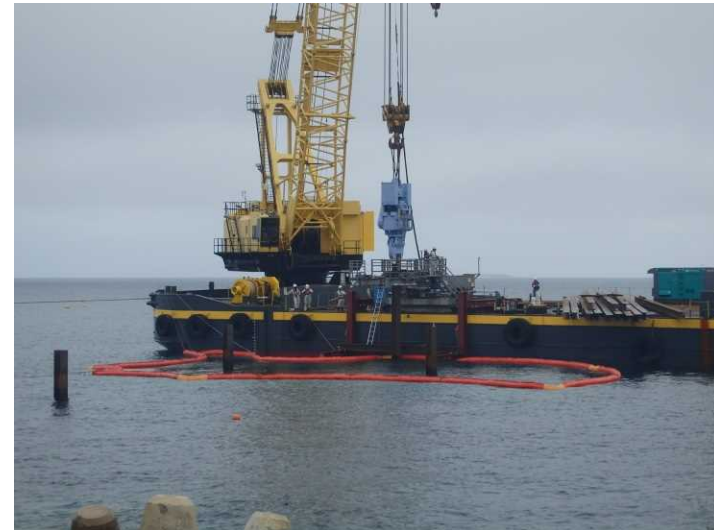
② 【北側進入灯】平成29年5月撮影
