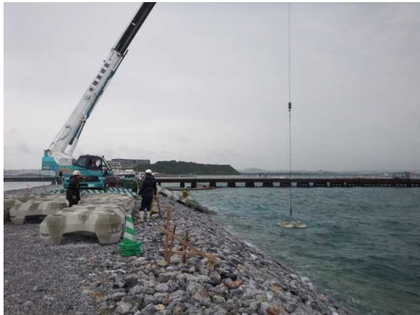
① 【I工区】被覆ブロック据付状況 (平成29年3月撮影)
