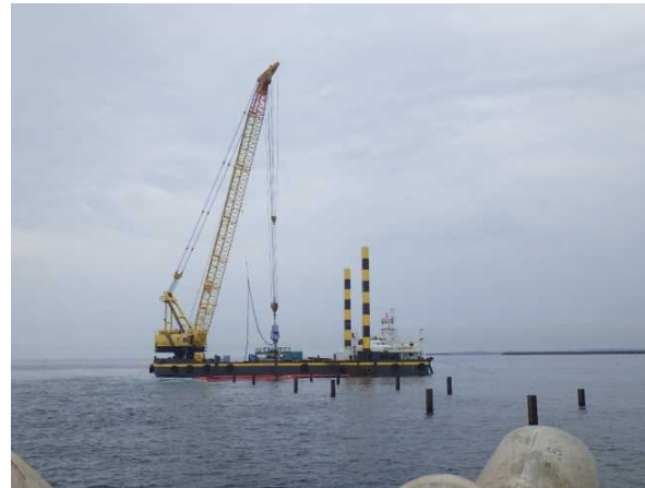
② 北側進入灯工事 杭打設状況 (平成29年5月撮影)
