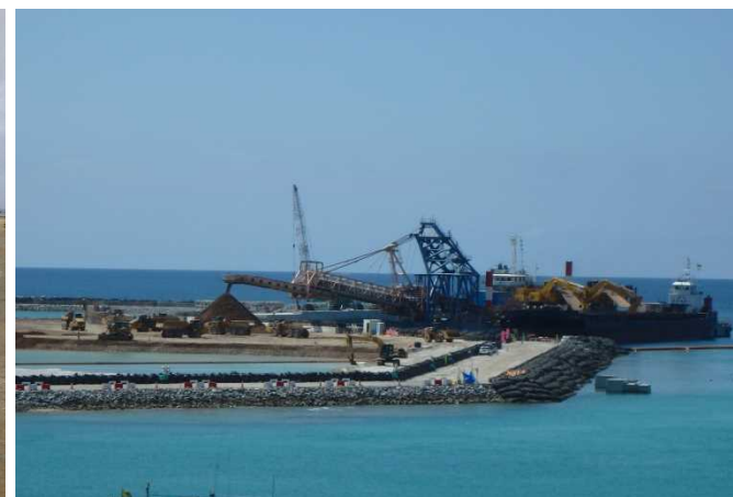
③ 【Ⅳ工区】岩ズリ投入状況 (平成29年6月撮影)
