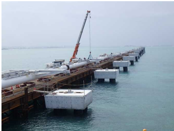
① 南側進入灯工事 橋梁上部工状況 (平成30年4月撮影)
