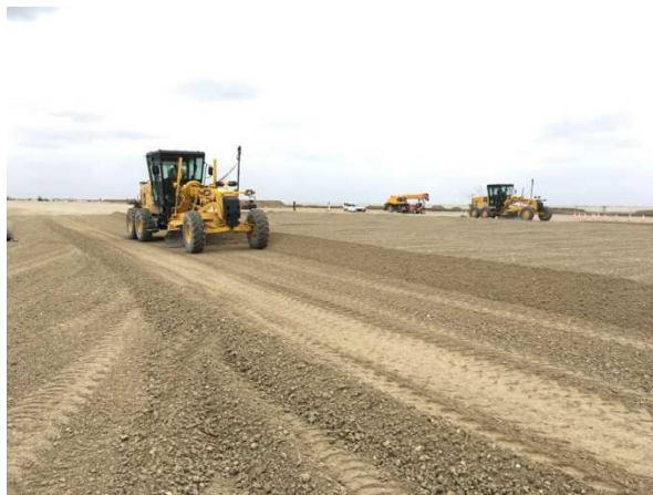
① 【Ⅲ工区】滑走路下層路盤敷設状況 (平成30年2月撮影)
