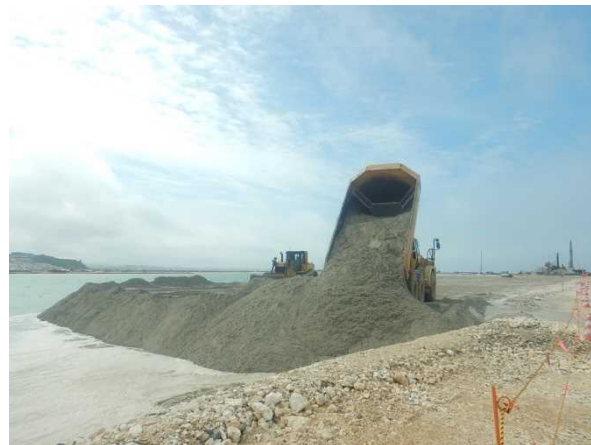
② 【I工区】海砂投入状況 (平成30年4月撮影)
