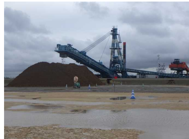
③ 【IV工区】岩ズリ揚土状況 (平成30年4月撮影)
