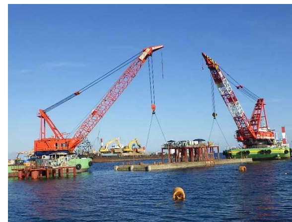
③ 【V工区】通水カルバート据付状況 (平成29年10月撮影) ※平成30年2月通水開始
