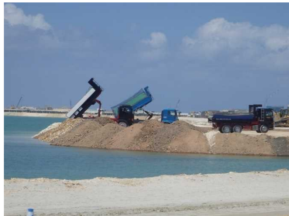
① 【I工区】岩ズリ投入状況 (平成30年3月撮影)
