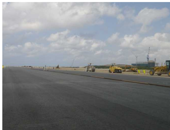
② 【Ⅲ工区】平行誘導路上層路盤状況 (平成30年3月撮影)
