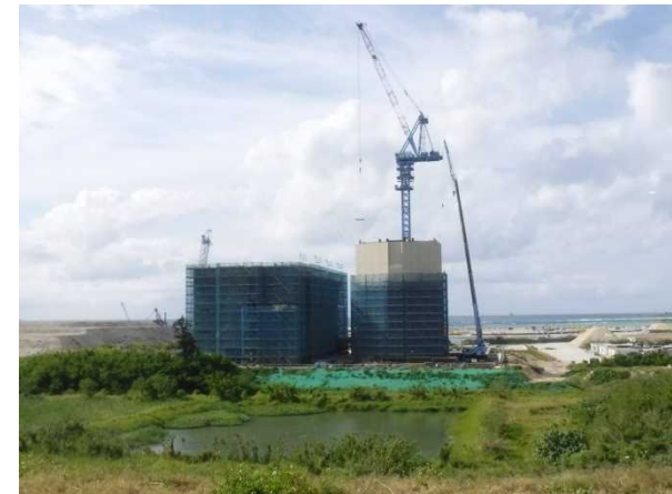
③ 管制塔工事 施工状況 (平成30年5月撮影)
