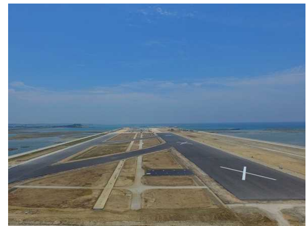
③ 【Ⅲ工区】滑走路・平行誘導路現況 (平成30年5月撮影)
