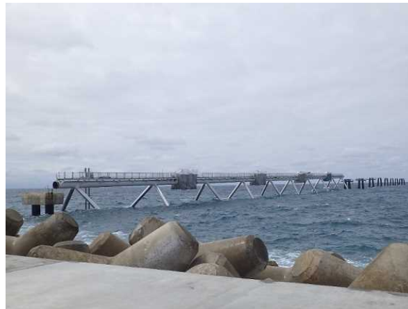
② 北側進入灯工事 橋梁上部工状況 (平成30年4月撮影)
