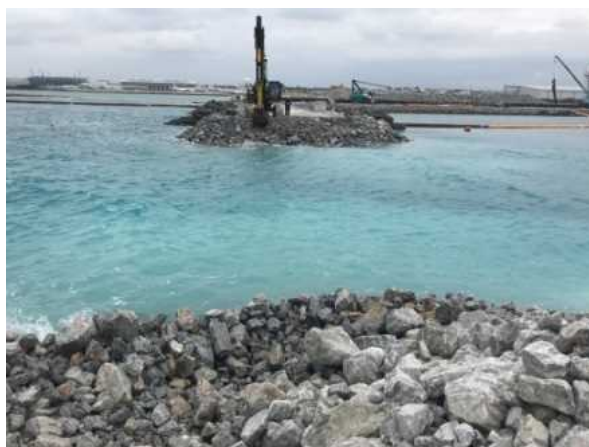
① 【V工区】護岸状況(概成前) (平成30年2月撮影)
