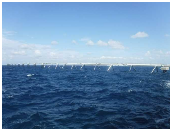
② 北側進入灯工事 橋梁上部工状況 (平成30年11月撮影)
