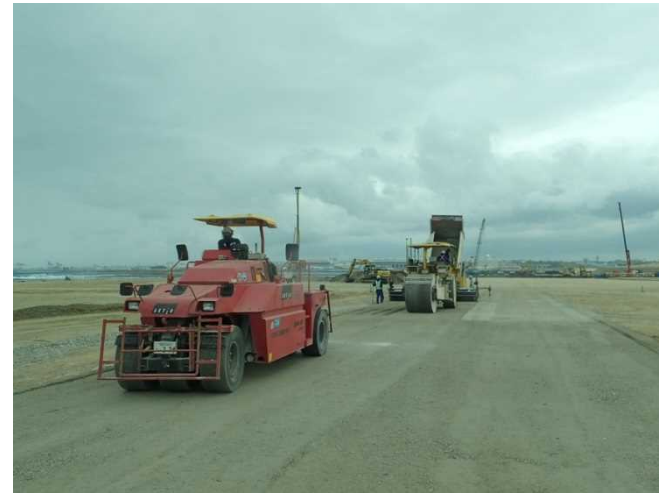
② 【Ⅳ工区】誘導路下層路盤転圧状況 (平成30年12月撮影)
