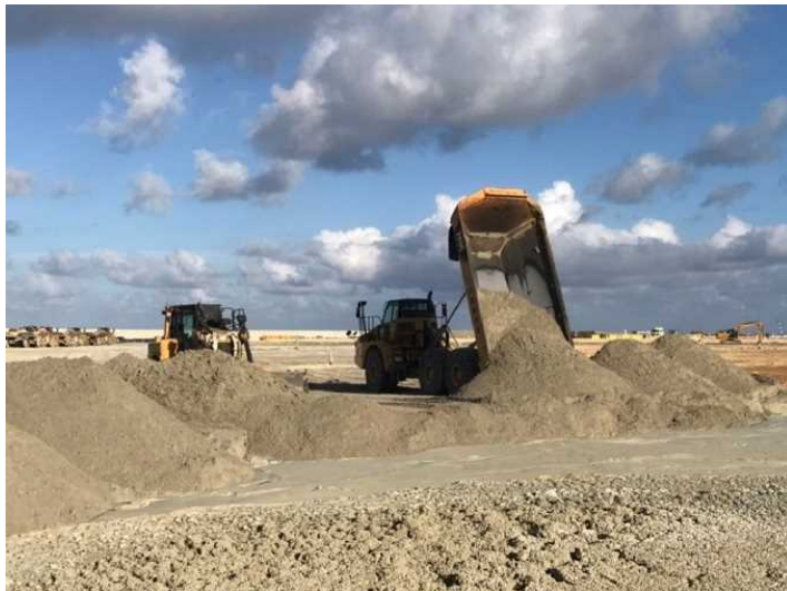
① 【I工区】海砂投入状況 (平成30年11月撮影)
