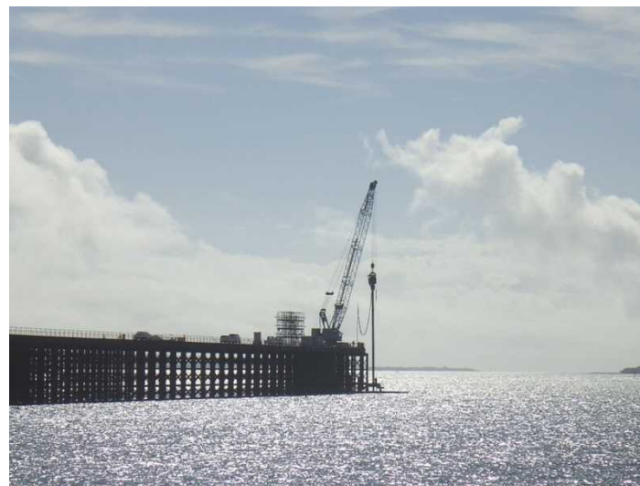
② 【南側進入灯】杭打設状況(平成30年12月撮影)
