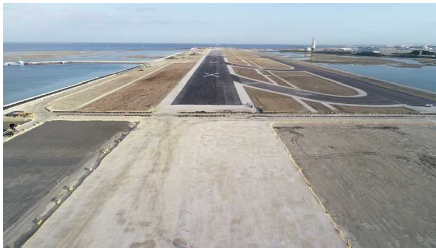
① 【Ⅱ工区(南側から撮影)】滑走路現況 (平成30年12月撮影)
