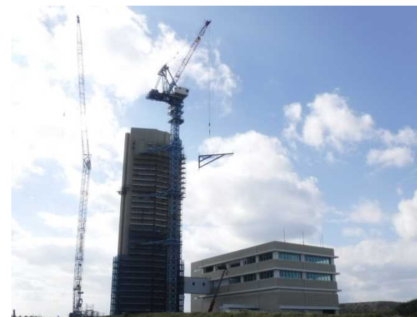
③ 管制塔工事 施工状況 (平成30年12月撮影)
