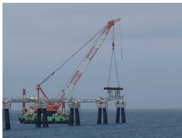
② 北側進入灯工事 桁架設状況 (平成31年4月撮影)
