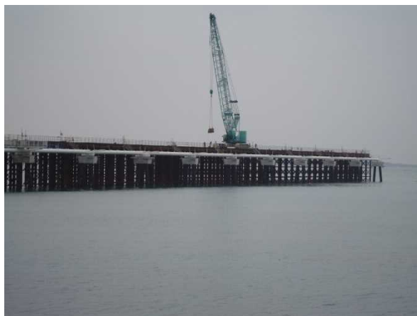
① 南側進入灯工事 桁架設状況 (平成31年4月撮影)
