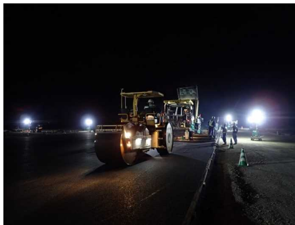
② 【IV工区】基層敷設・転圧状況 (令和元年5月撮影)
