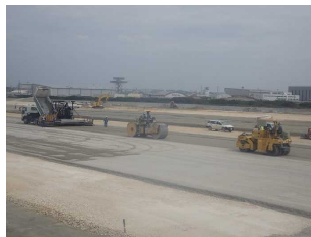
③ 【V・VI工区】下層路盤敷設・転圧状況 (平成31年4月撮影)
