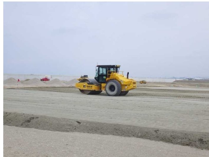
② 【IV工区】転圧状況 (平成31年3月撮影)
