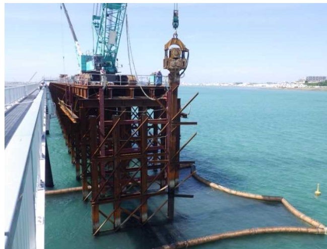
①【南側進入灯作業構台】杭引抜作業 (令和元年5月撮影)
