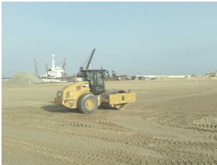
① 【I工区】転圧状況 (平成31年2月撮影)
