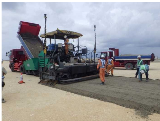
① 【I工区】下層路盤敷設状況 (令和元年5月撮影)
