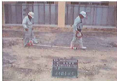
磁気探査状況
