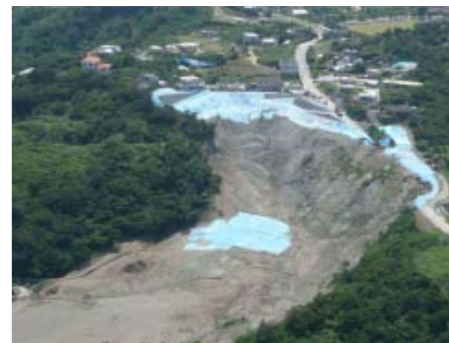
被災現場状況(防災ヘリからの映像)
