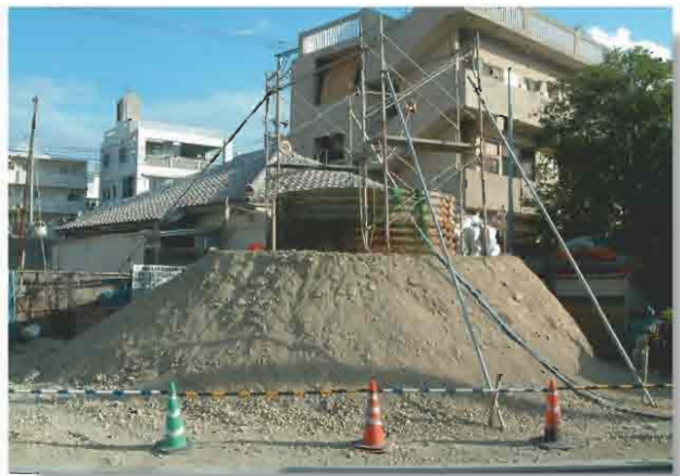
▲強固な防護壁による現場処理
