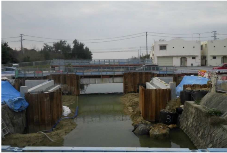
平成29年2月 橋台工(躯体工)・仮設工(土留・仮締切工)
