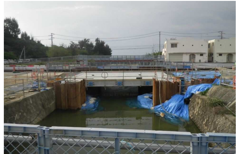
平成29年3月 PC橋工(桁架設)
