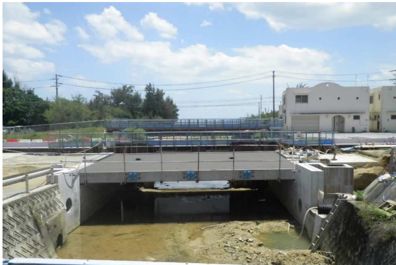
平成29年 4月 舗装工(橋面防水)・橋台工(作業土工、踏掛版)
