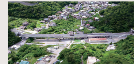
数久田高架橋
