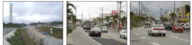
〈B.P 工事状況〉 金武中学校付近
