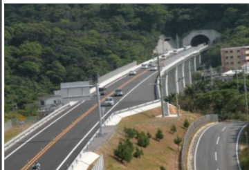
伊差川IC交差点から名護大北トンネルを望む
