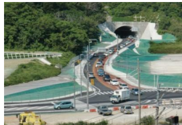
世富慶IC交差点から幸地又トンネルを望む
