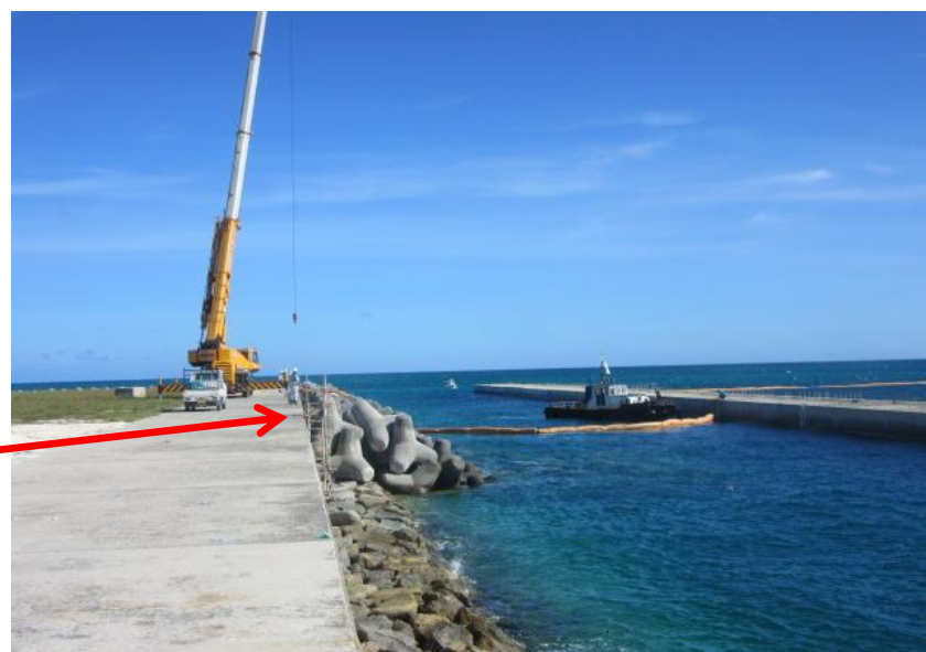
② 岸壁(-10m) 平成28年7月
