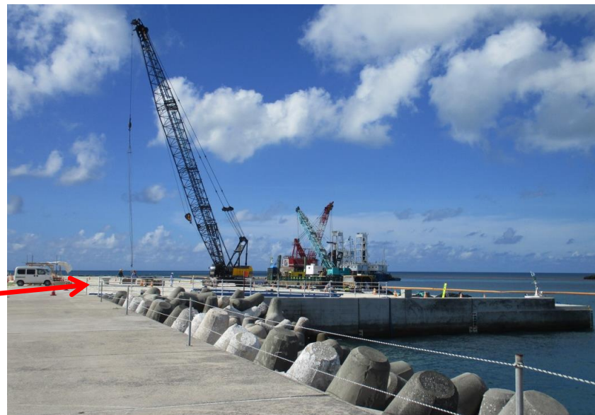
② 岸壁(-10m) 平成29年8月
