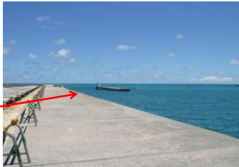
② 岸壁(-10m) 平成27年7月
