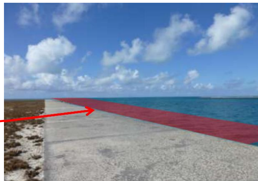
② 岸壁(-10m) 平成26年7月
