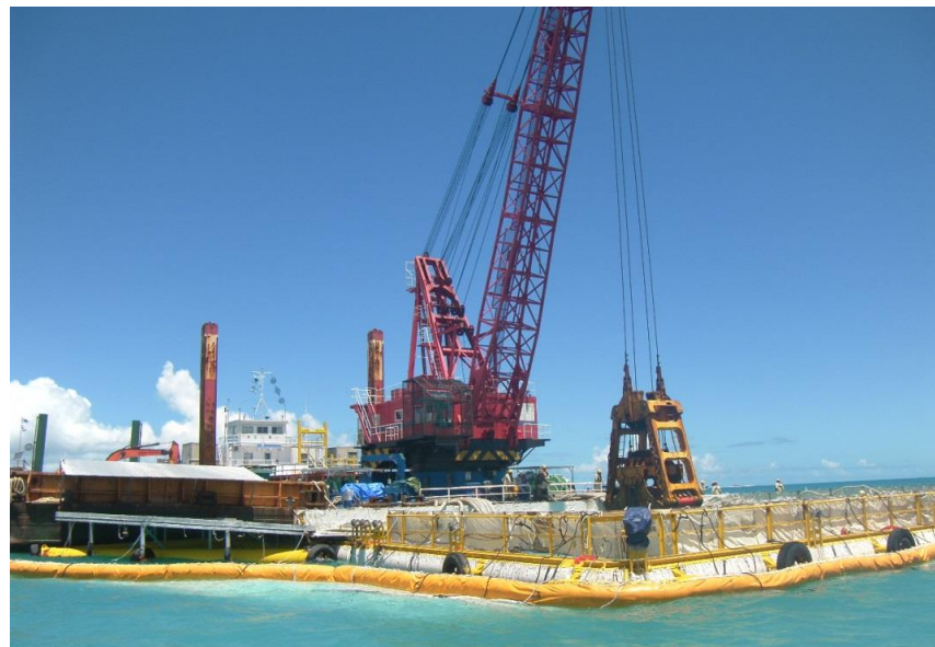
グラブ浚渫状況
