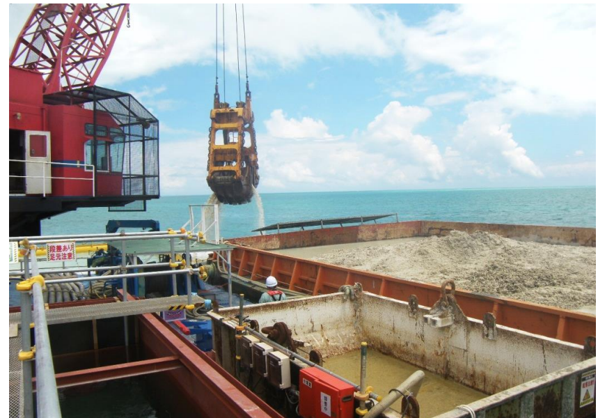
土砂台船積み込み状況
