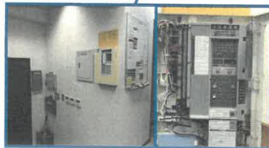
二階御殿 1F 事務室内
