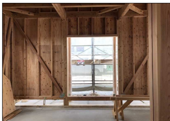
令和3年11月（施工中）
