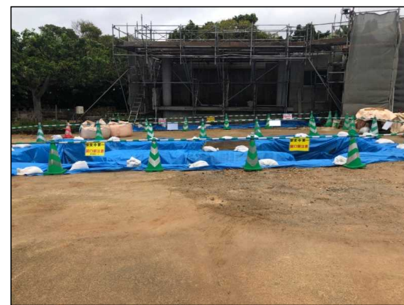
令和3年12月（施工中）
