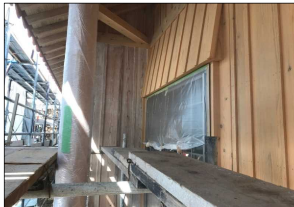
令和4年1月（施工中）
