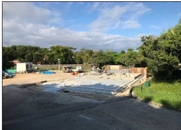
令和3年10月（施工中）
