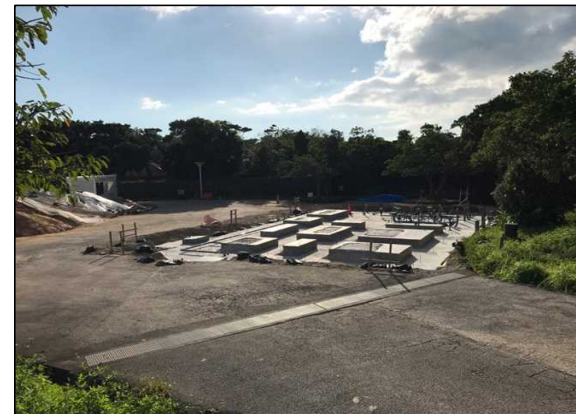
令和3年8月（施工中）
