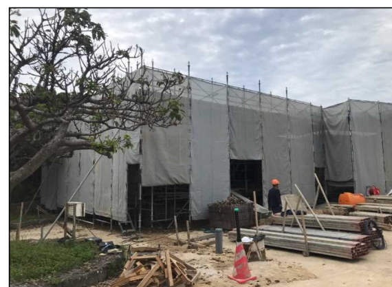
令和3年11月（施工中）
