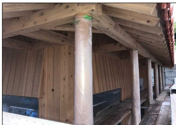
令和4年1月（施工中）
