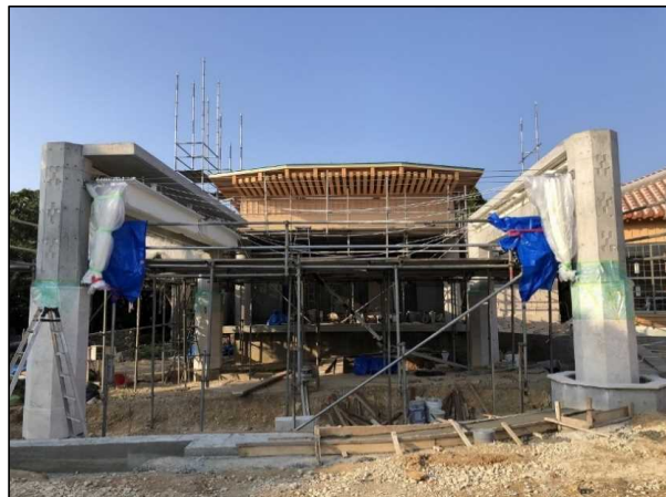
令和4年2月（施工中）
