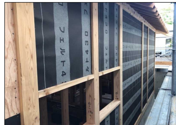
令和3年11月（施工中）
