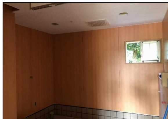
令和4年2月（施工中）
