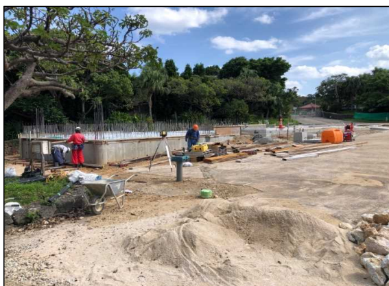
令和3年10月（施工中）
