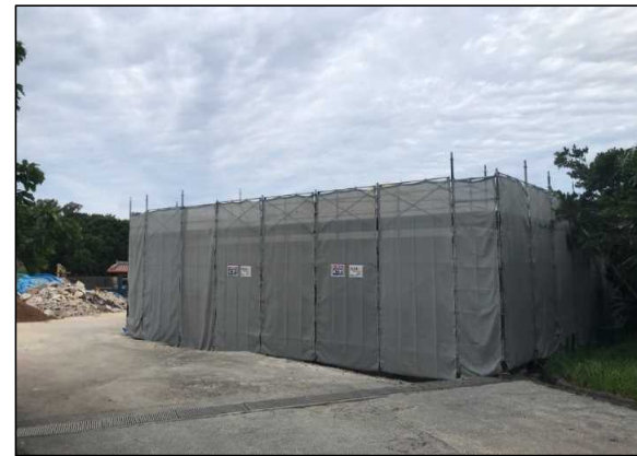
令和3年11月（施工中）
