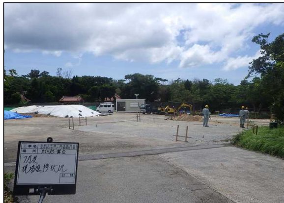
令和3年7月（施工中）
