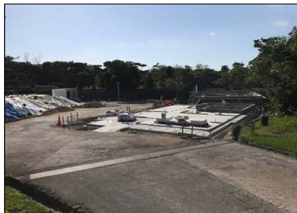
令和3年9月（施工中）
