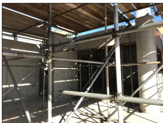
令和3年11月（施工中）
