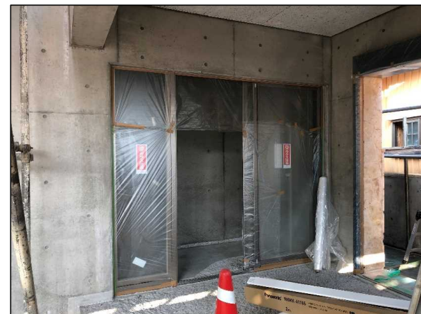
令和4年2月（施工中）
