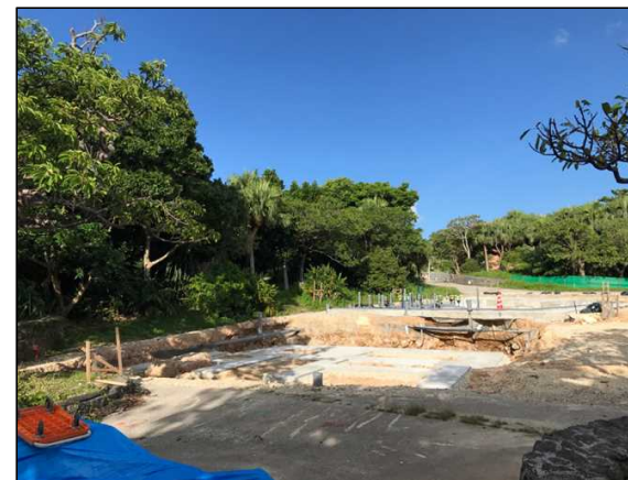
令和3年8月（施工中）
