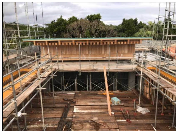
令和4年1月（施工中）
