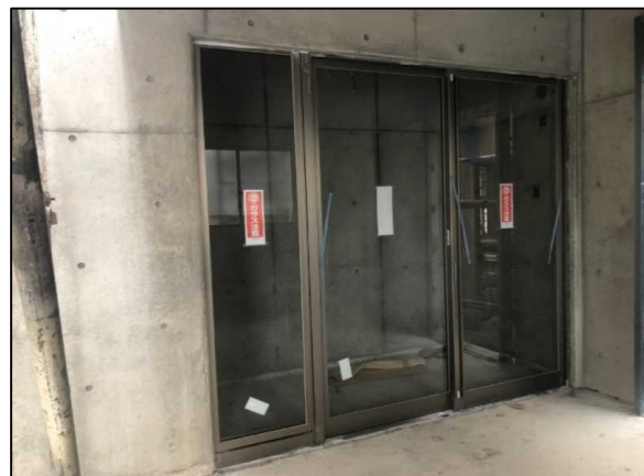
令和3年12月（施工中）
