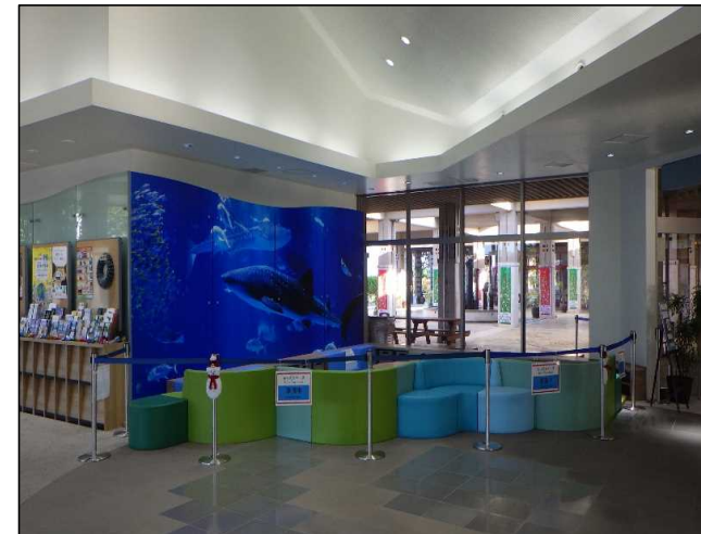
令和3年11月（施工中）
