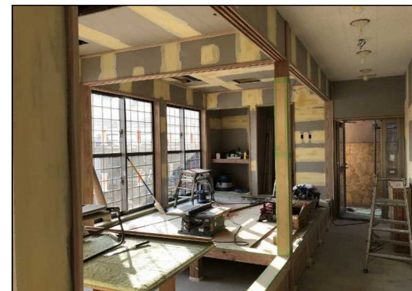
令和4年2月（施工中）
