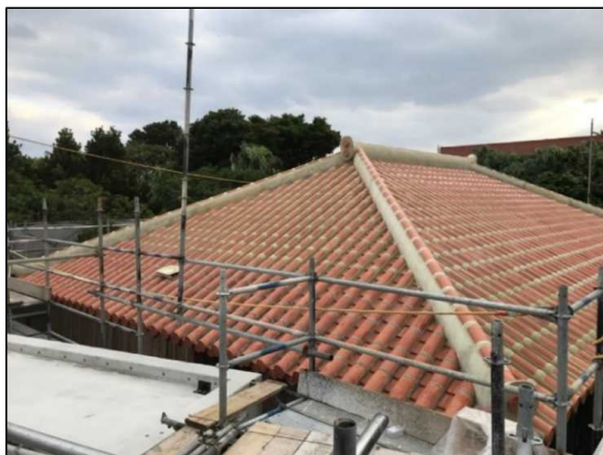
令和3年12月（施工中）
