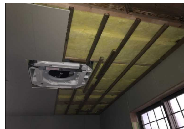
令和4年1月（施工中）
