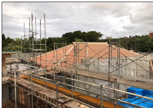
令和4年1月（施工中）
