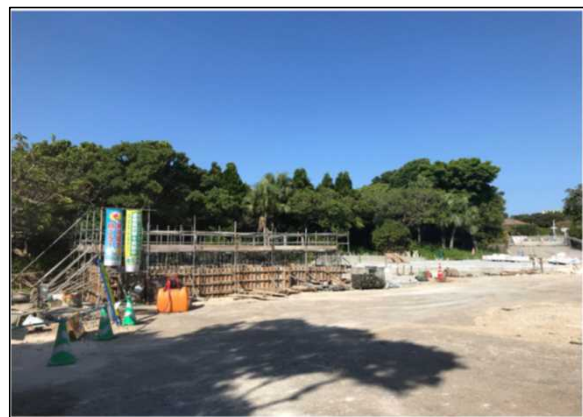
令和3年9月（施工中）
