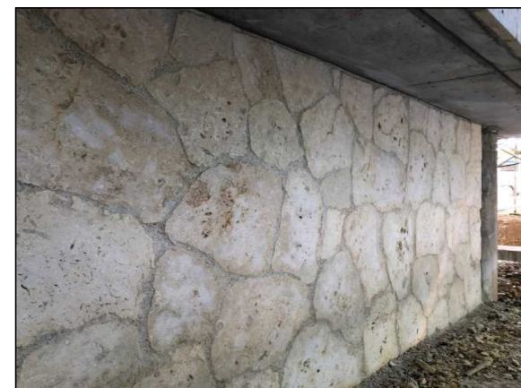
令和4年1月（施工中）
