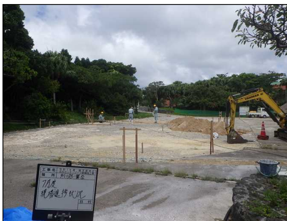
令和3年7月（施工中）
