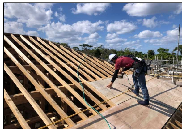
令和3年12月（施工中）
