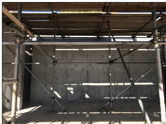
令和3年11月（施工中）
