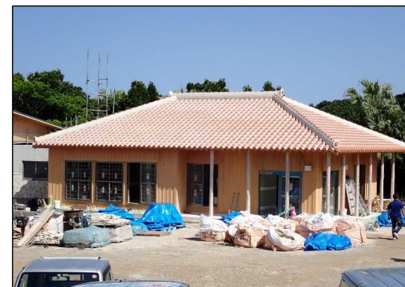
令和4年2月（施工中）
