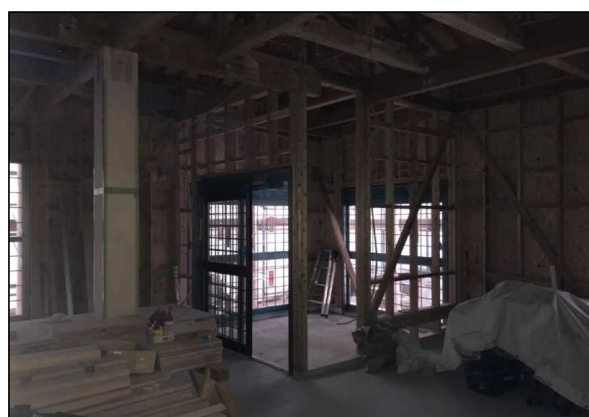
令和3年12月（施工中）
