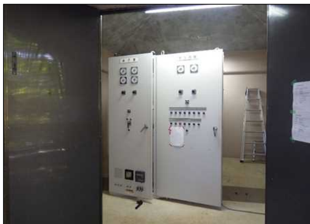
令和3年8月（施工前）
