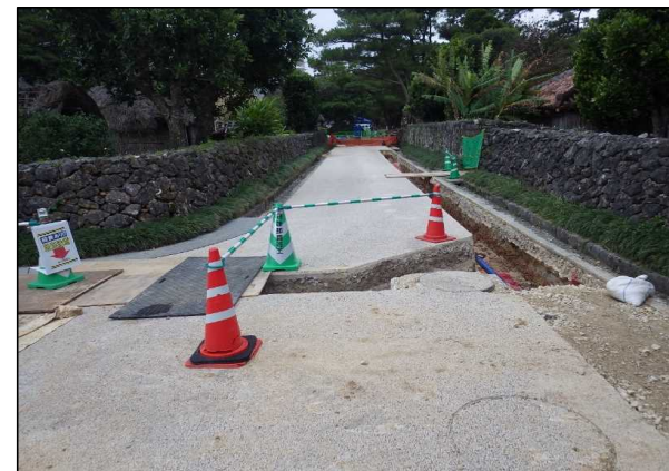
令和4年1月（施工中）
