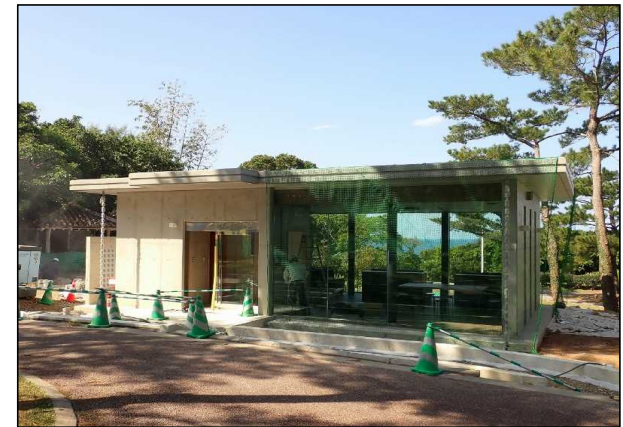
令和4年2月（施工中）
