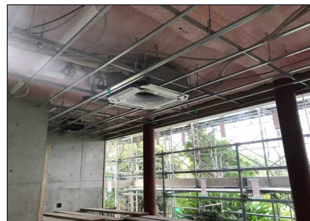
令和3年12月（施工中）
