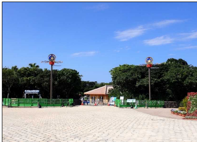
令和4年2月（施工中）
