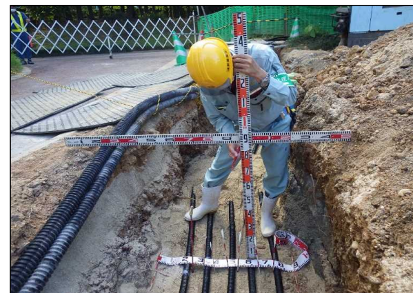
令和3年10月（施工中）
