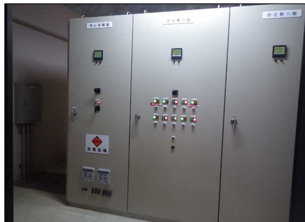
令和3年12月（完成）
