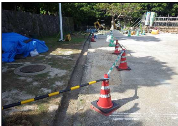
令和3年9月（施工中）
