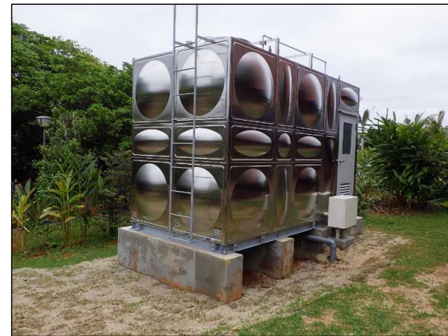
令和4年3月（完成）
