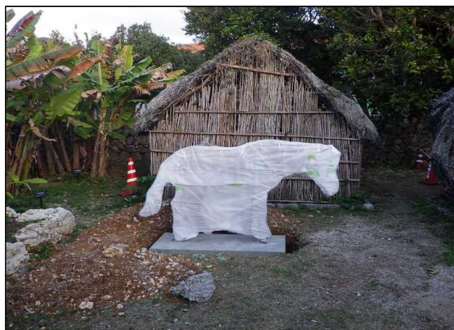
令和4年1月（施工中）
