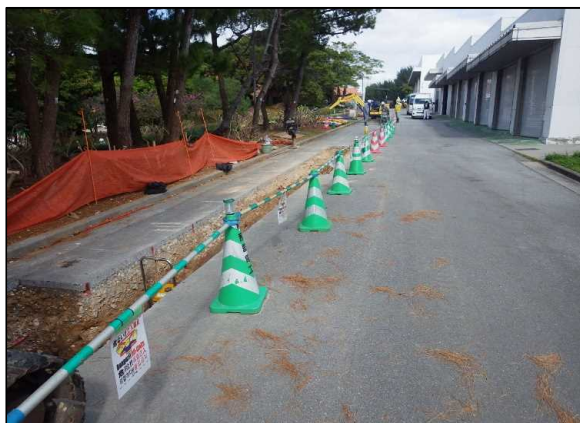
令和4年1月（施工中）
