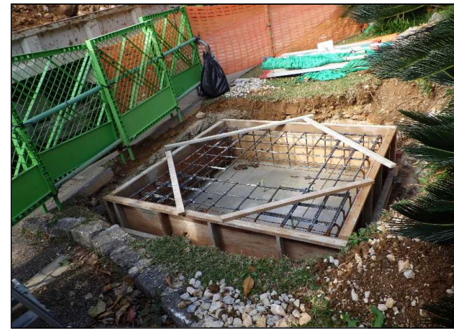
令和3年12月（施工中）
