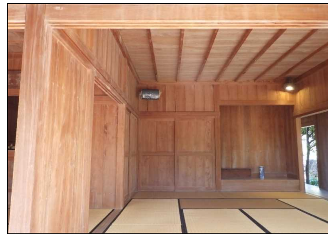
令和4年2月（施工中）
