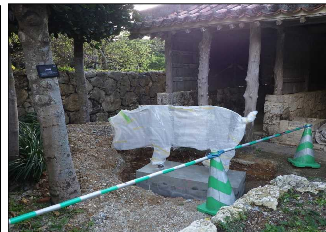
令和4年1月（施工中）
