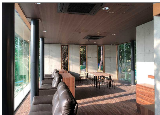
令和4年2月（施工中）
