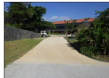
令和3年9月（完成）
