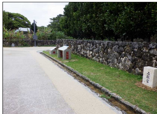
令和4年3月 (完成)
