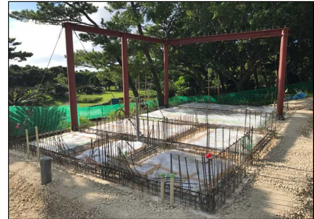
令和3年8月（施工中）
