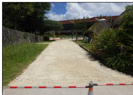
令和3年8月（施工中）
