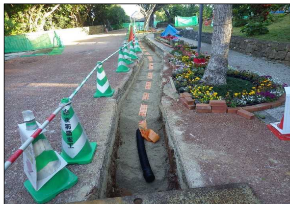
令和4年2月（施工中）
