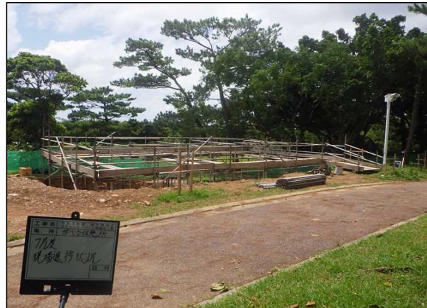
令和3年7月（施工中）
