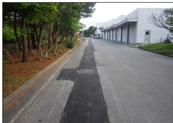
令和4年3月（完成）
