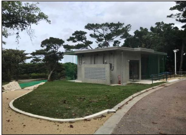
令和4年3月（完成）
