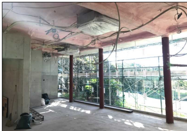
令和3年11月（施工中）
