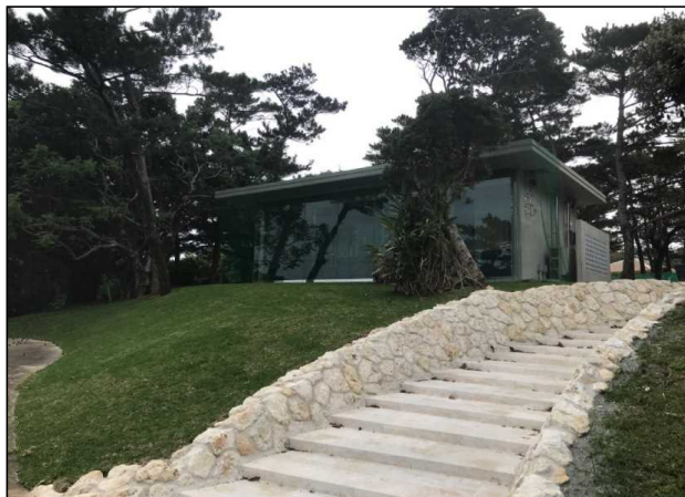
令和4年3月（完成）
