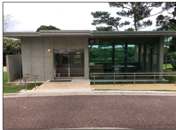
令和4年3月（完成）
