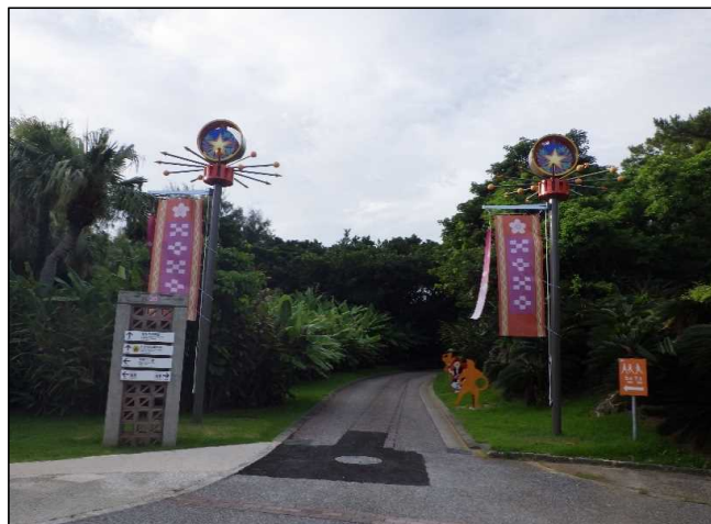
令和4年3月（完成）
