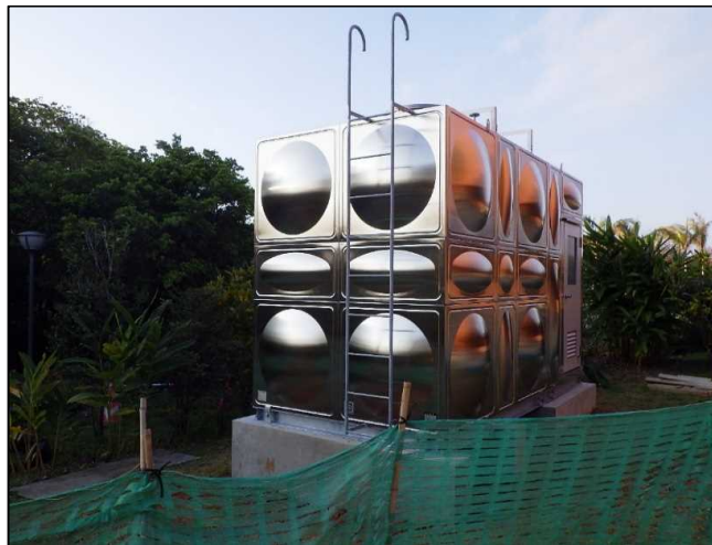
令和4年2月（施工中）
