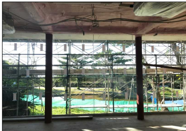
令和3年11月（施工中）
