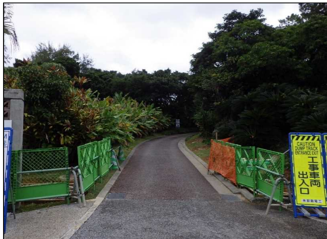
令和3年12月（施工中）
