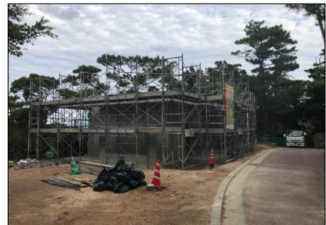
令和3年11月（施工中）
