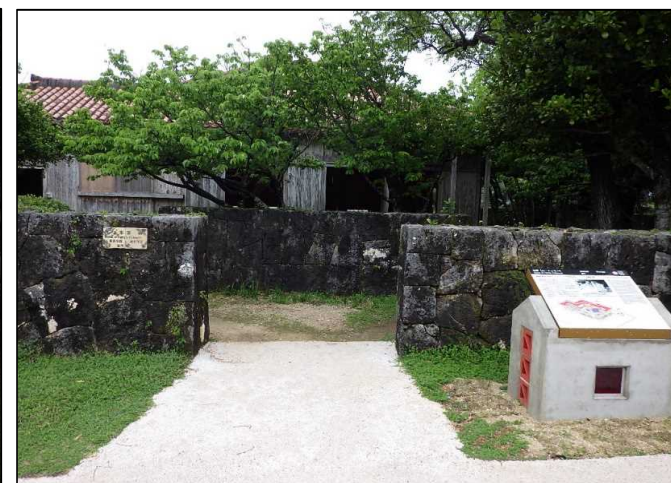
令和4年3月 (完成)
