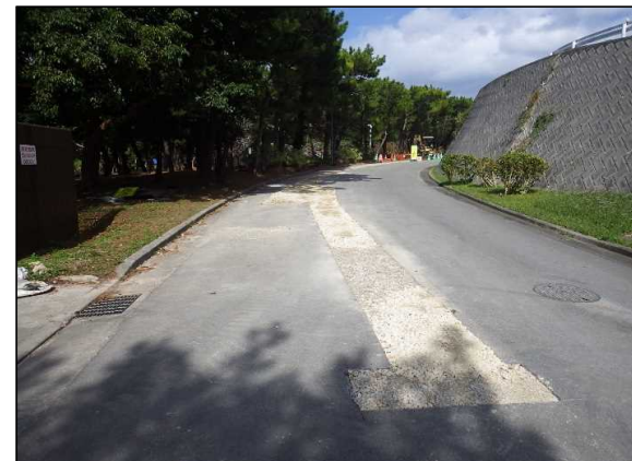
令和4年1月（施工中）
