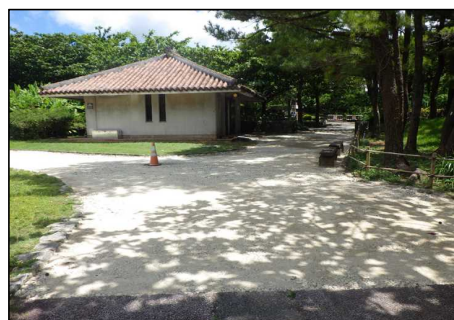
令和3年8月（施工中）
