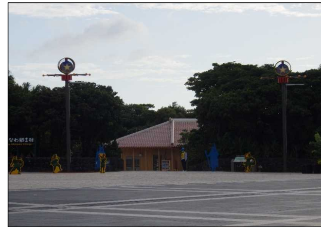
令和4年3月（完成）
