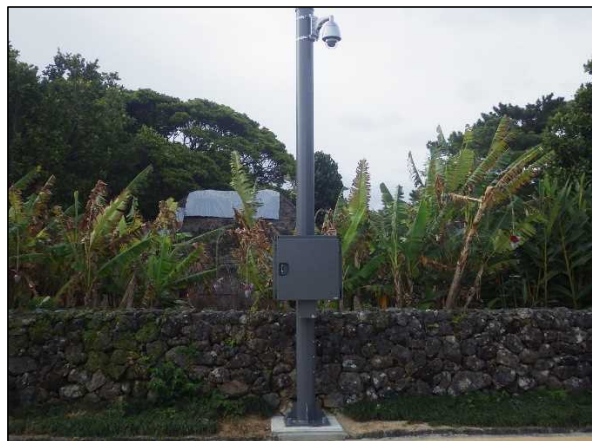
令和4年3月（完成）
