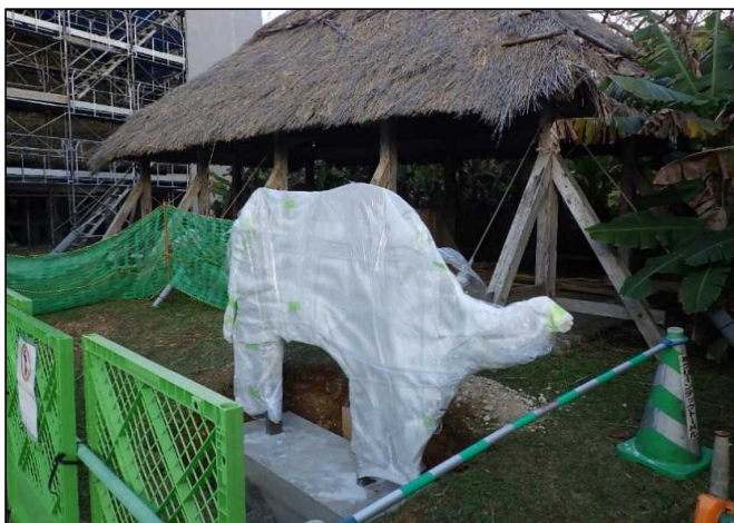
令和4年1月（施工中）
