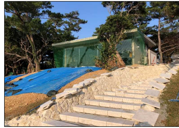
令和4年2月（施工中）
