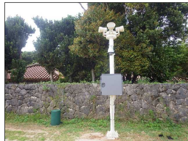
令和4年3月（完成）
