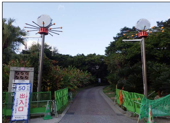
令和4年1月（施工中）
