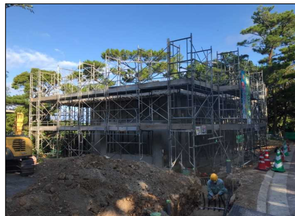
令和3年10月（施工中）
