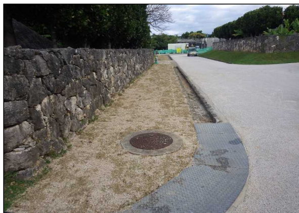
令和3年12月（施工中）
