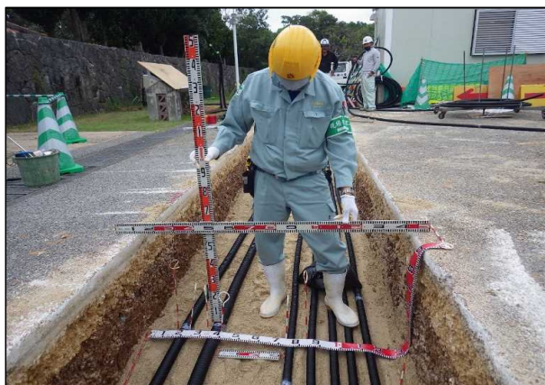
令和3年11月（施工中）
