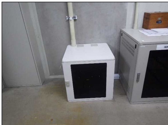
令和4年3月（完成）
