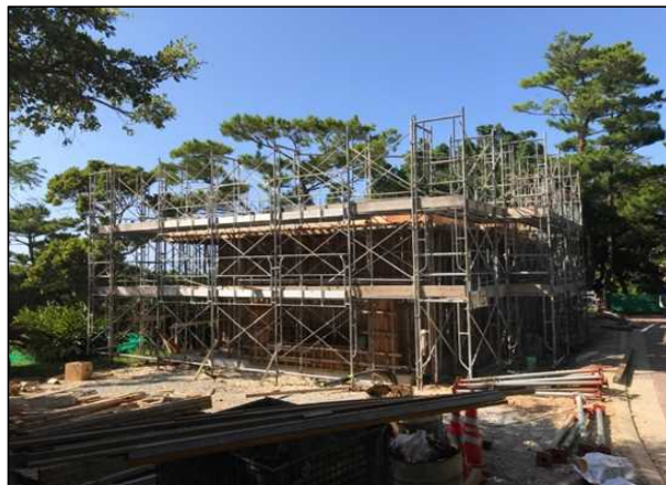
令和3年9月（施工中）
