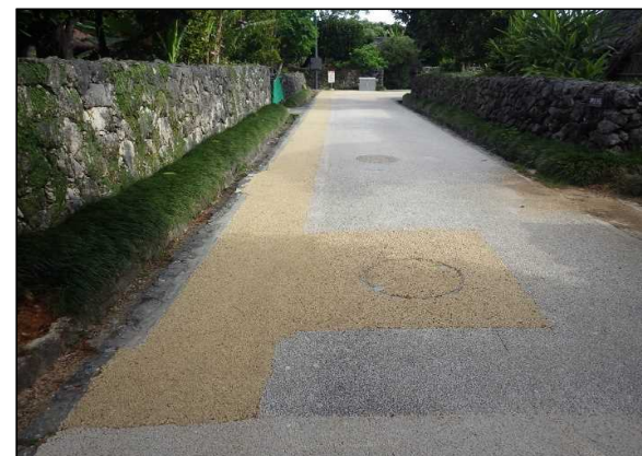
令和4年3月（完成）
