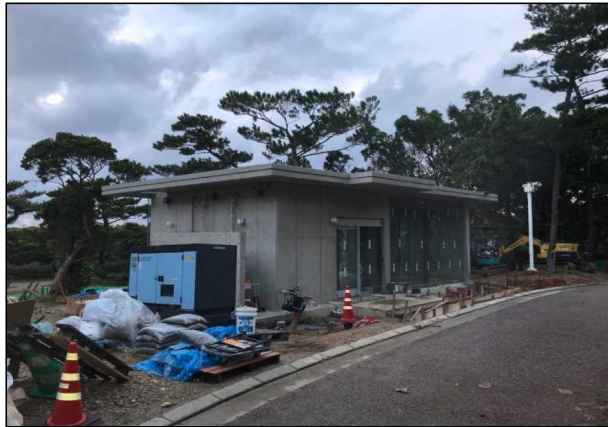
令和4年1月（施工中）
