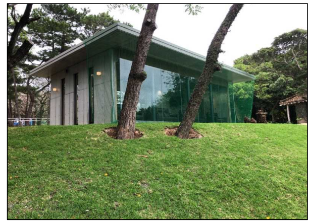
令和4年3月（完成）
