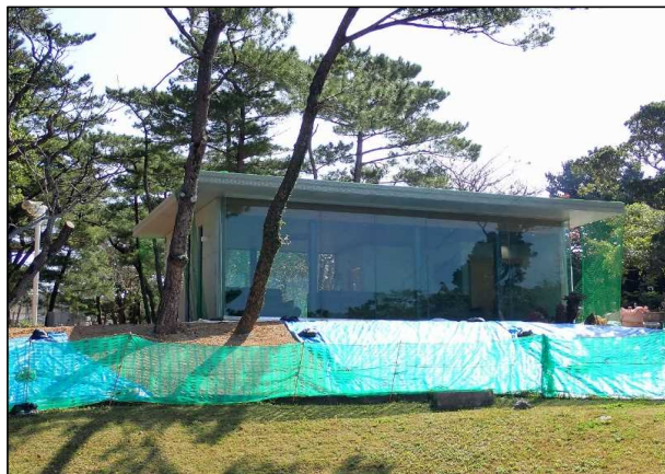
令和4年2月（施工中）
