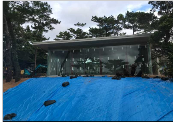
令和4年1月（施工中）
