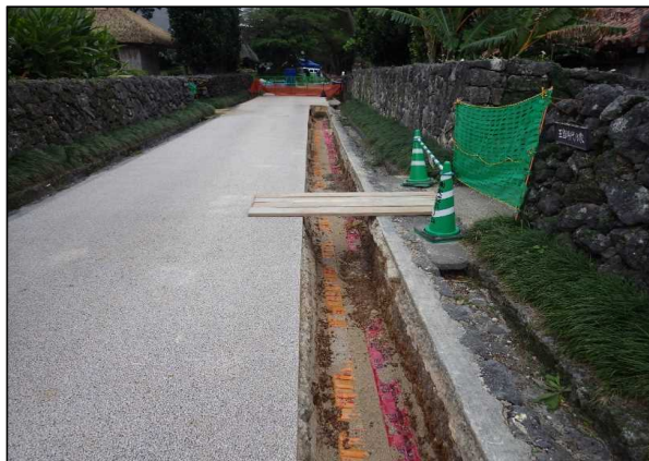
令和4年1月（施工中）
