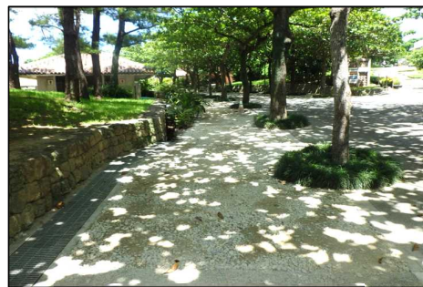
令和3年8月（施工中）
