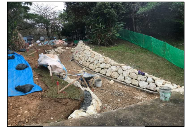
令和4年2月（施工中）
