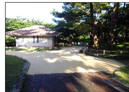
令和3年9月（完成）
