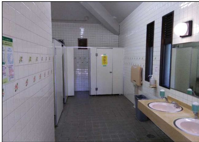
令和3年10月（施工前）
