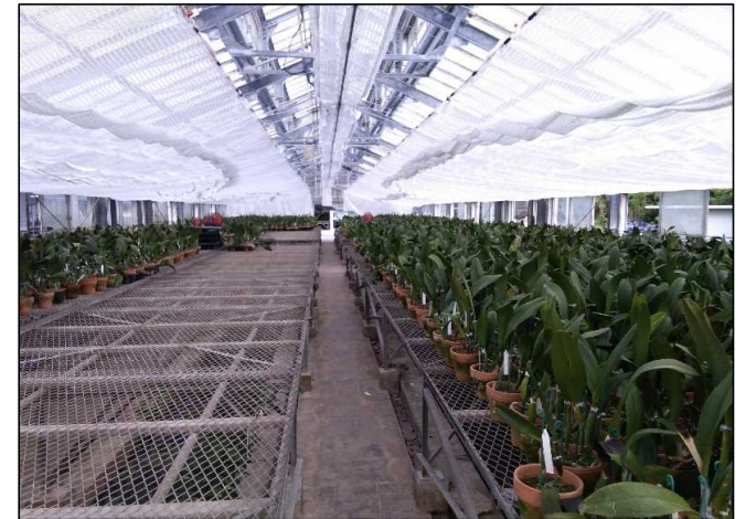
令和4年3月（完成）
