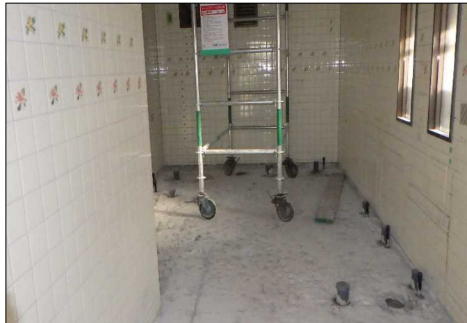
令和3年11月（施工中）
