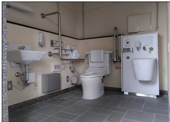
令和4年3月 (完成)
