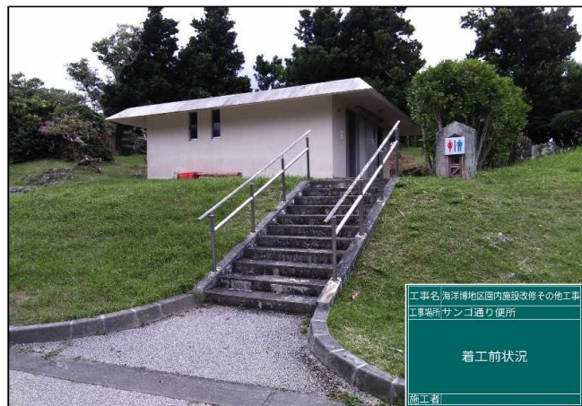
令和3年10月（施工前）
