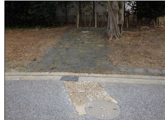
令和3年12月 (完成)
