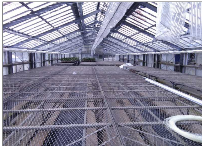
令和4年3月（完成）
