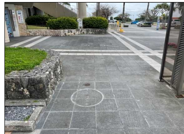
令和4年1月 (完成)
