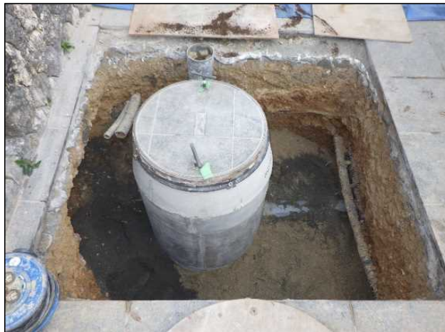
令和4年1月 (施工中)
