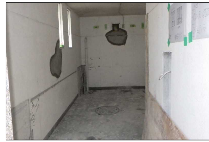
令和3年11月（施工中）
