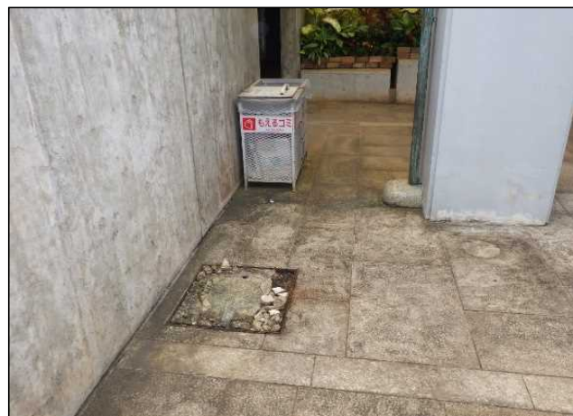
令和4年1月（施工前）
