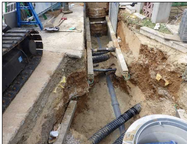
令和4年2月（施工中）
