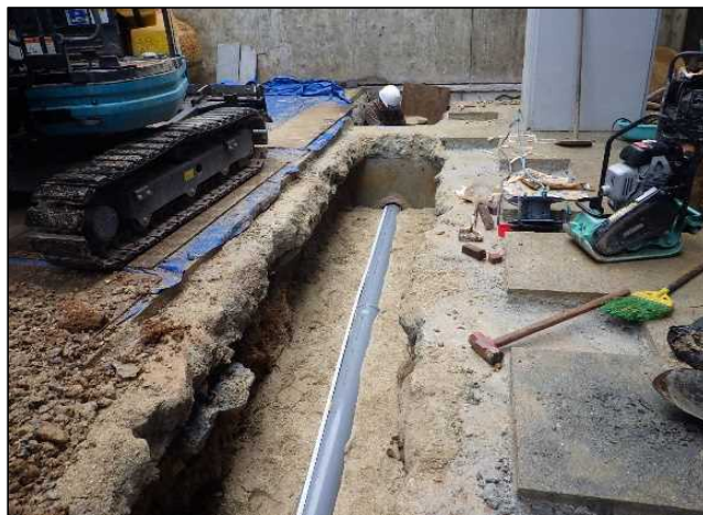
令和4年2月（施工中）
