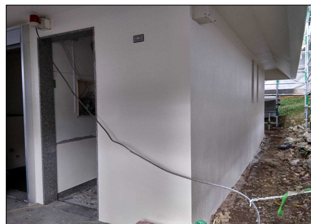
令和4年1月（施工中）
