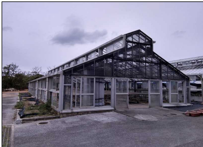
令和3年12月（施工中）
