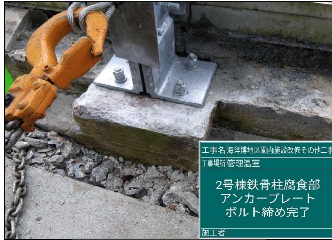
令和4年2月（施工中）
