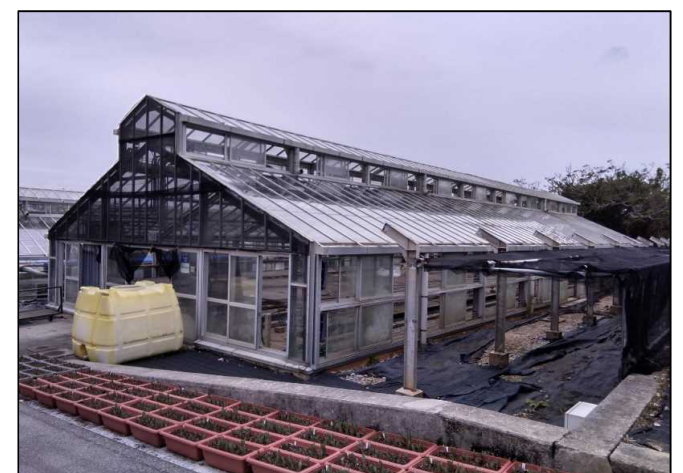
令和3年12月（施工中）
