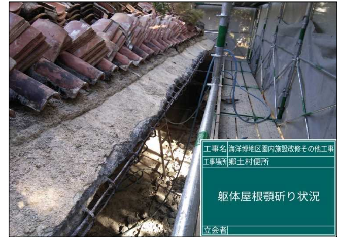
令和3年11月（施工中）
