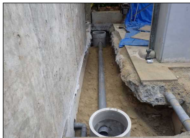
令和4年1月（施工中）
