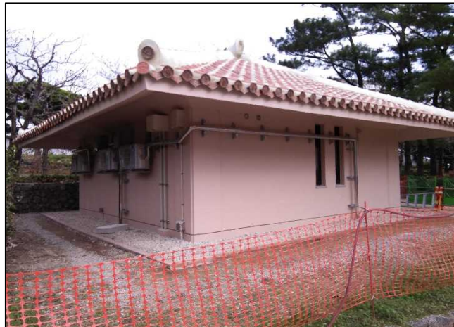
令和4年3月（完成）
