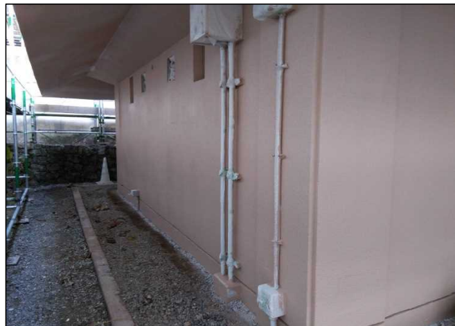
令和4年1月（施工中）
