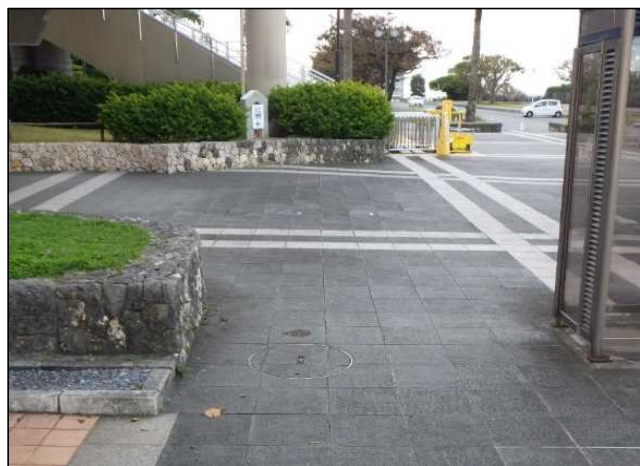
令和3年12月 (施工前)
