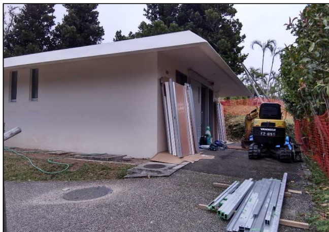
令和4年2月（施工中）
