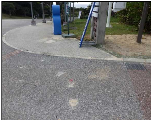
令和4年1月（施工前）
