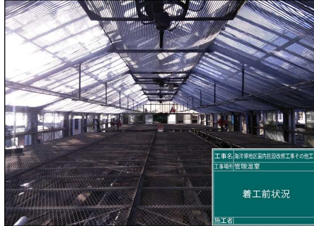
令和3年11月（施工前）
