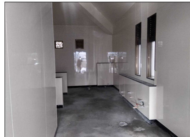
令和4年1月（施工中）
