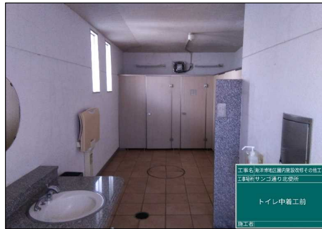
令和3年10月（施工前）
