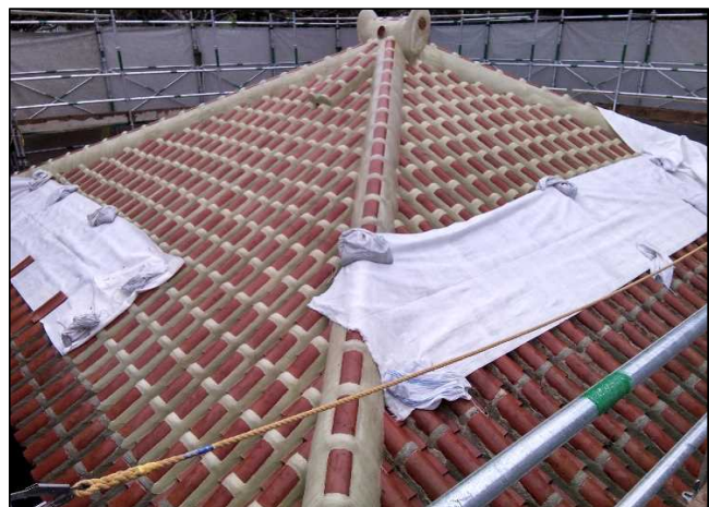
令和4年2月（施工中）
