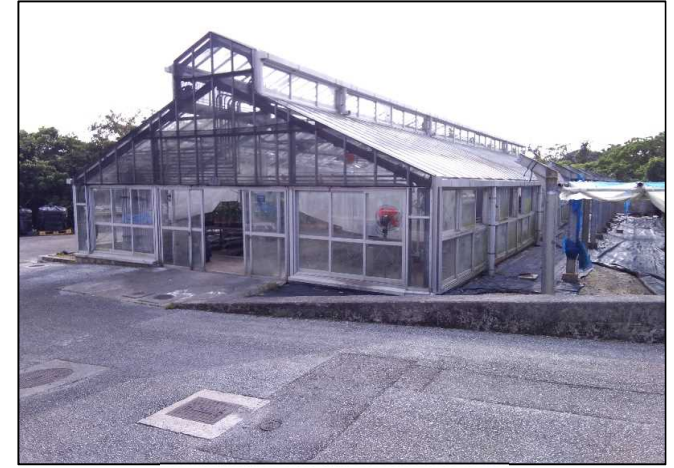
令和4年3月（完成）
