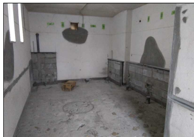
令和3年12月（施工中）
