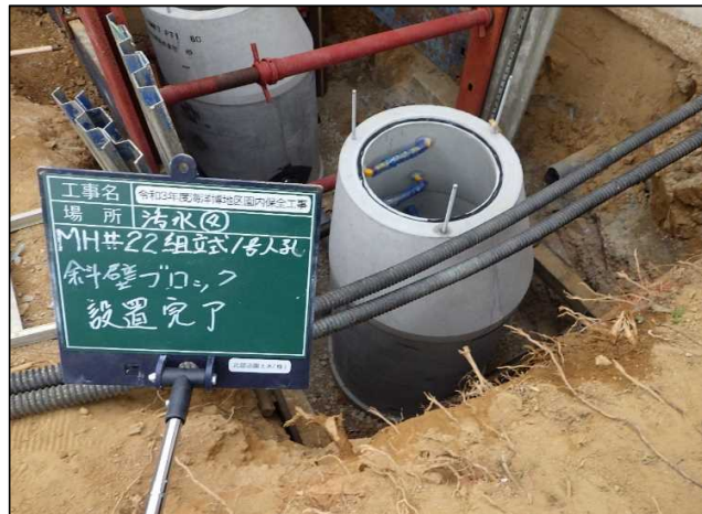
令和3年11月 (施工中)
