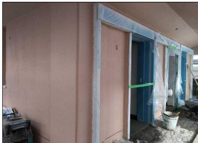
令和4年1月（施工中）
