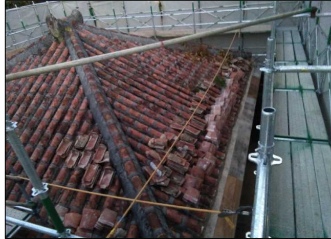
令和3年11月（施工中）
