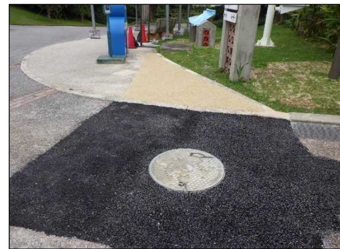
令和4年3月（完成）
