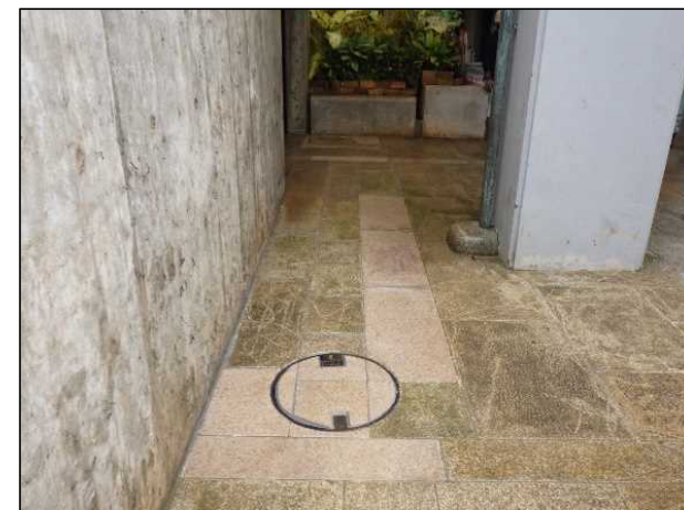
令和4年2月（完成）
