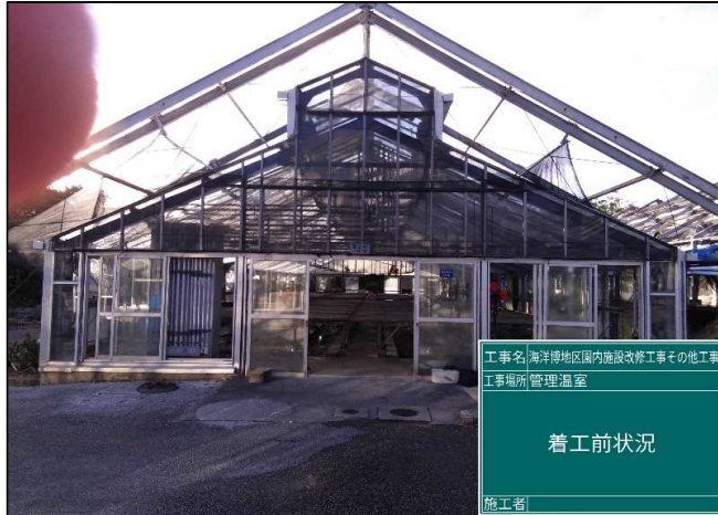
令和3年11月（施工前）
