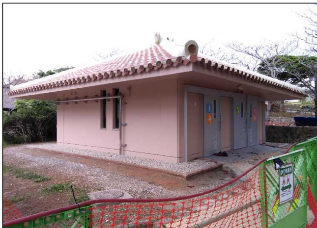
令和4年3月（完成）
