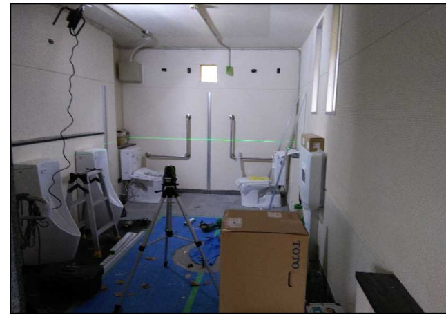
令和4年2月（施工中）
