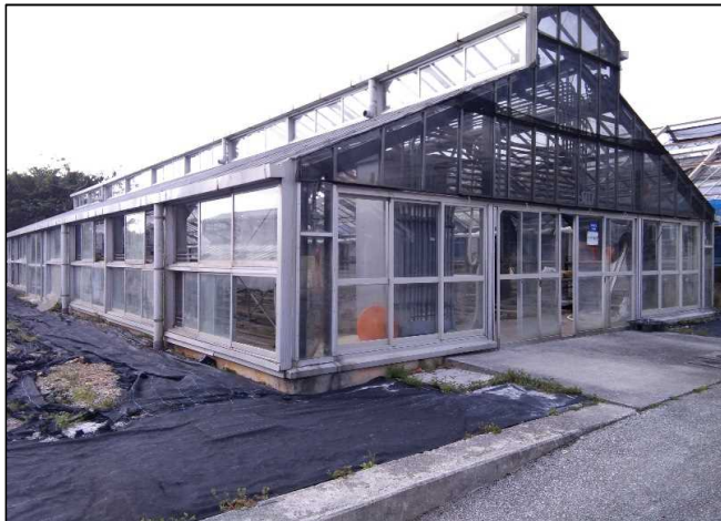
令和4年3月（完成）
