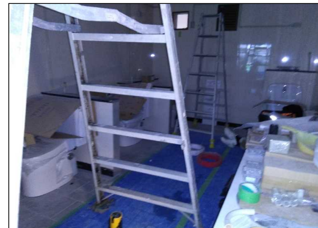
令和4年2月（施工中）
