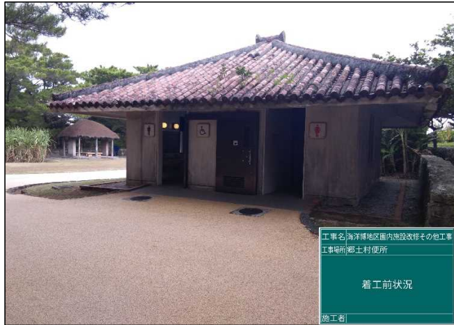
令和3年10月（施工前）
