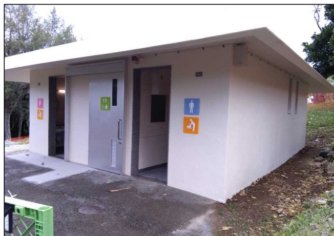
令和4年3月（完成）
