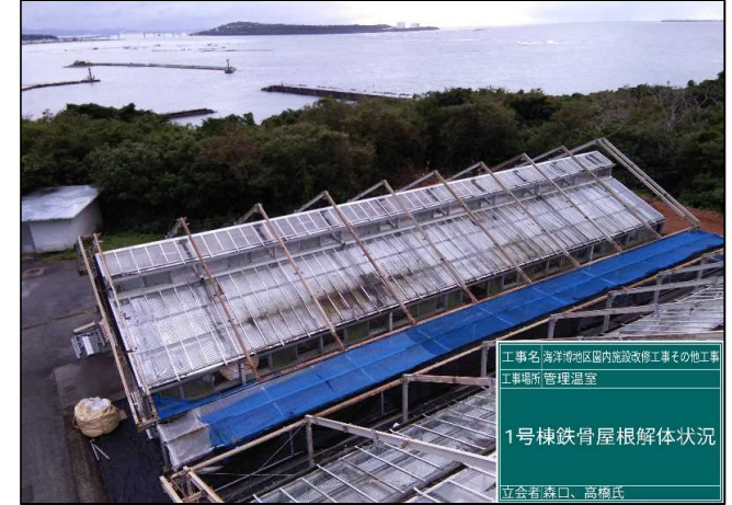
令和3年11月（施工中）
