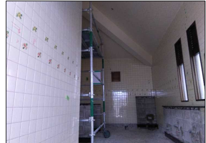
令和3年12月（施工中）
