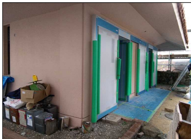
令和4年2月（施工中）
