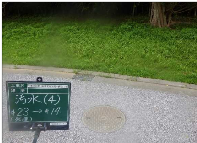
令和3年10月 (施工前)
