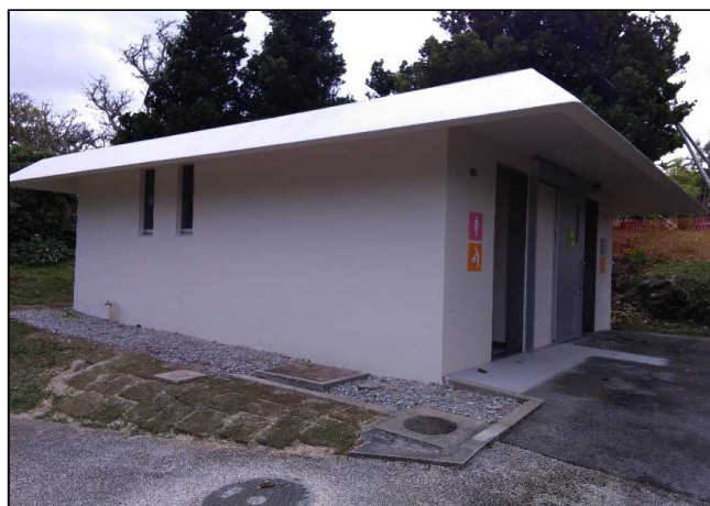
令和4年3月（完成）
